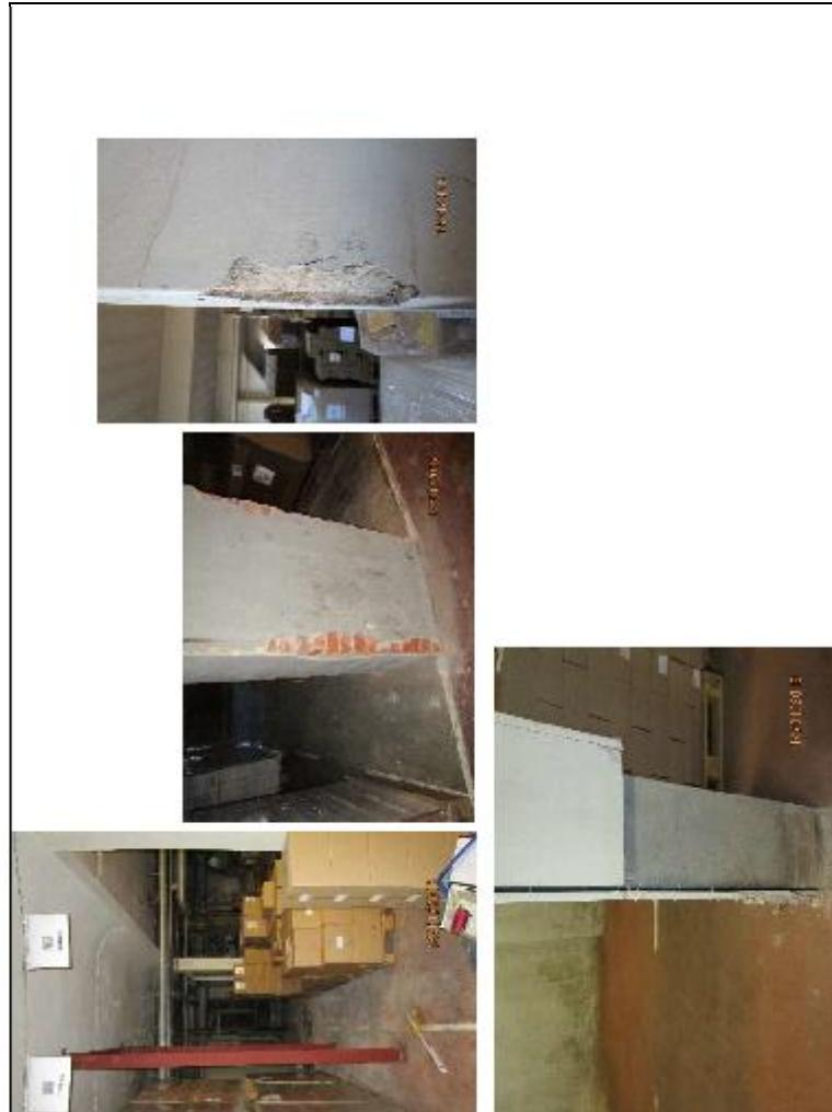
**Bild 30:** Geb. 5, Stützen teils aus Stahl, Ziegelmauerwerk, verputzter Beton, verkleideter Beton
