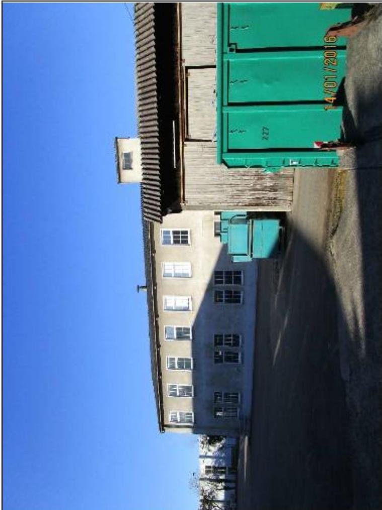
**Bild 21:** Gebäude 10 (vorne) und 12 (hinten), Geb. 10 - Holzschuppen mit Wellasbest-Dach, Geb. 12 – Massivbau mit Wellasbest-Dach
