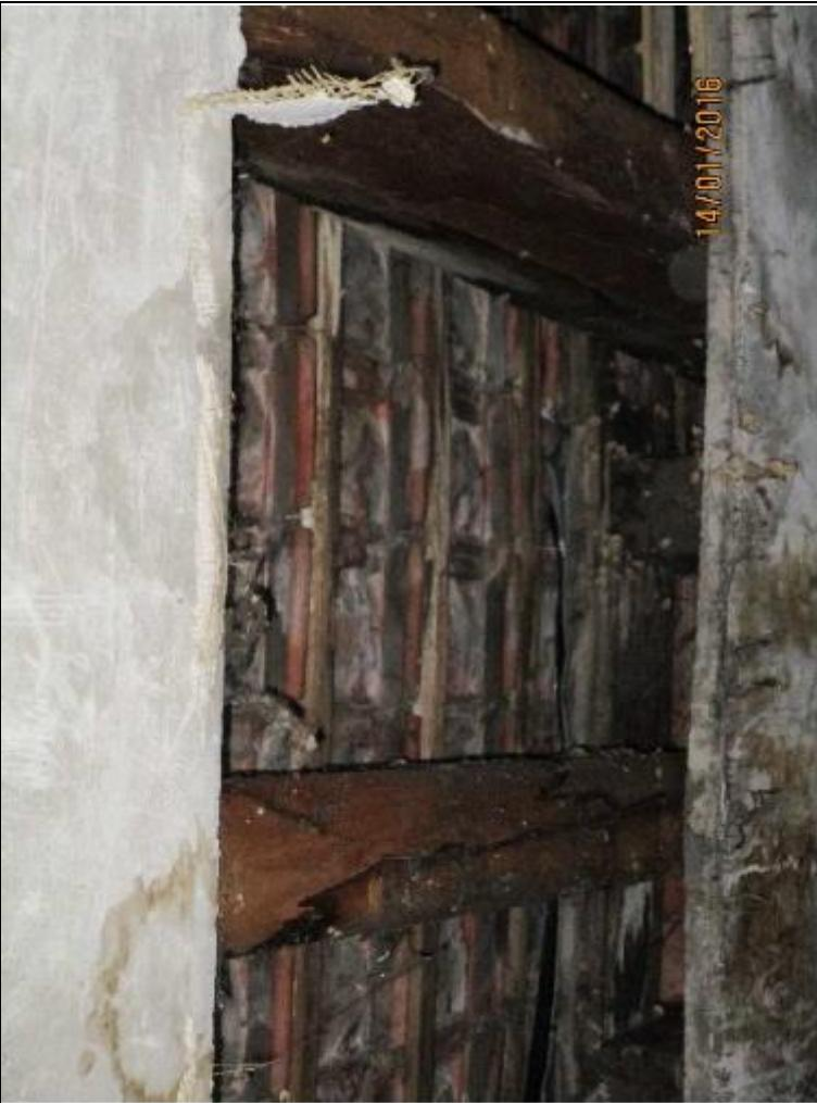
**Bild 25:** Geb. 5, DG, Satteldach mit Verkleidung, Probe BS7, Asbest nicht nachweisbar
