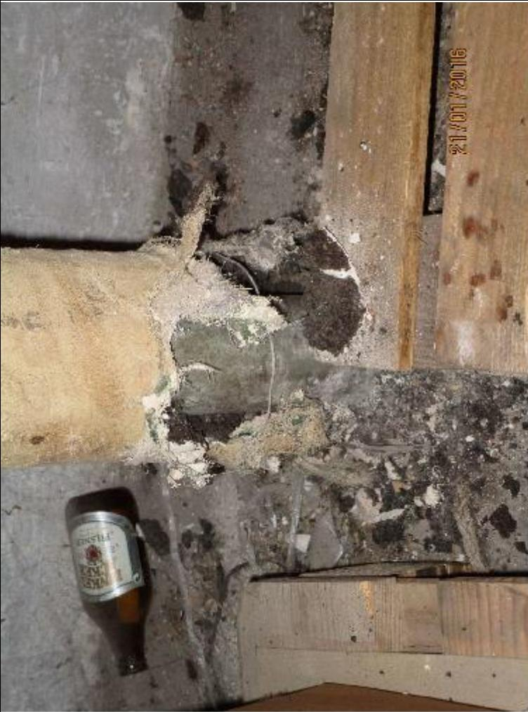
**Bild 27:** Geb. 5, DG, Rohr mit Korkummantelung, Probe BS8, PAK 14.000 mg/kg
