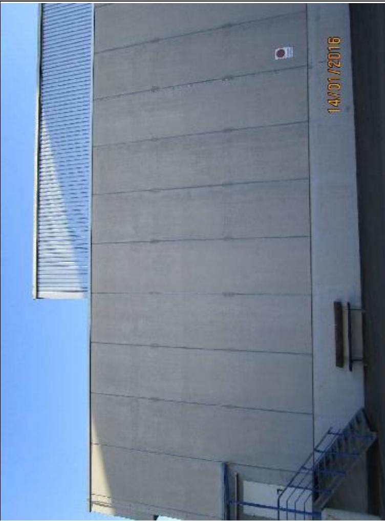
**Bild 31:** Fassade Geb. 3, Betonfertigteilelemente mit dauerel. Fugen, PCB-frei
