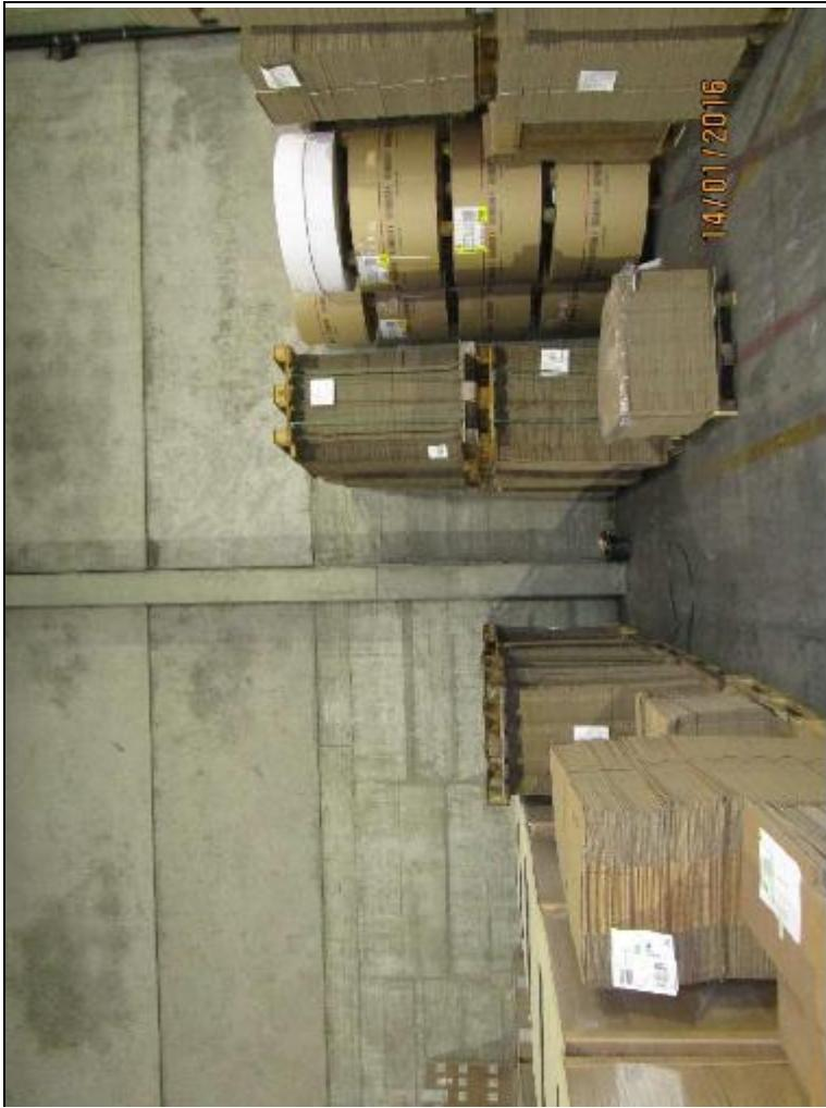
**Bild 33:** Geb. 1, Hochregallager, Zwischenwand aus Betonfertigbauteilen mit dauerel. Fugen, PCB-frei
