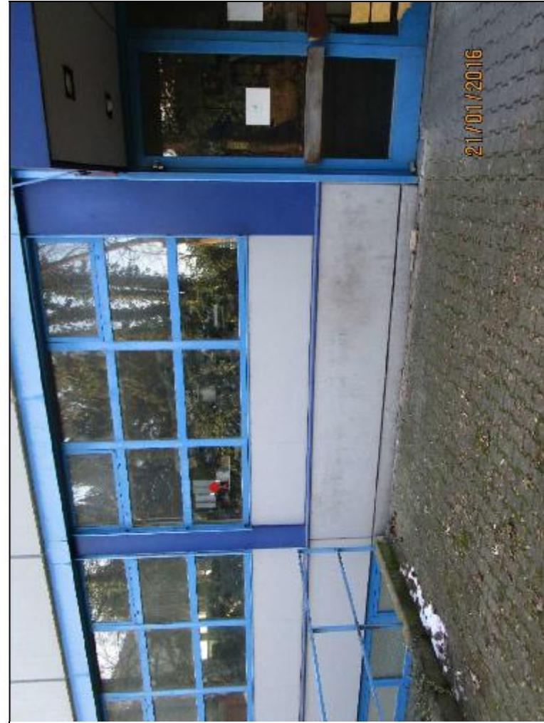
**Bild 36:** Geb. 1, Ost-Fassade, Fensterkassetten vermutlich asbesthaltig
