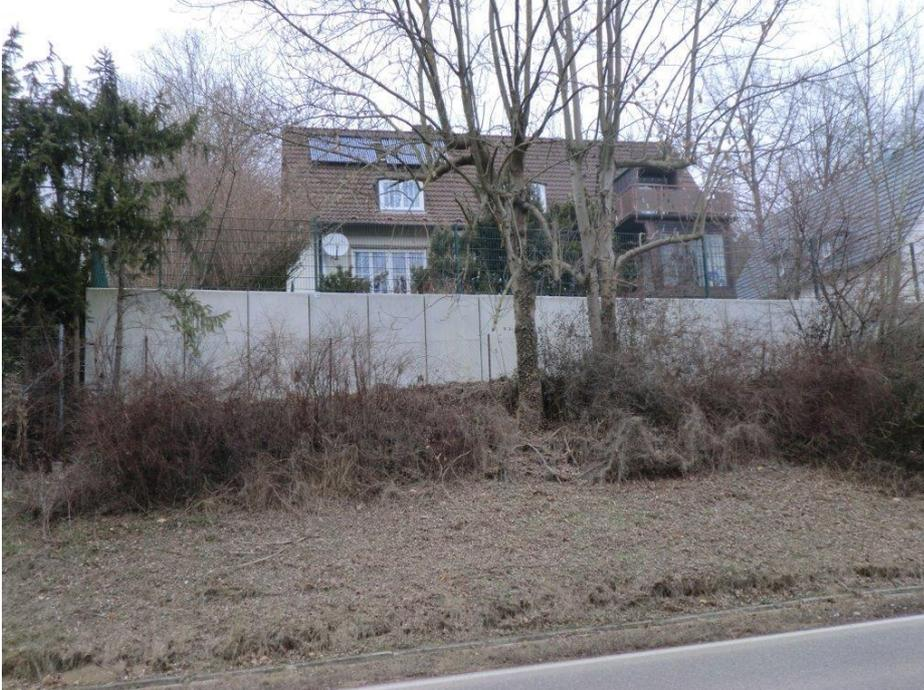
Bei dieser Wand wurden die Grundsätze, dass zur Reduzierung der innerörtlichen Immissionsbelastung solche Maßnahmen schallabsorbierend ausgeführt werden sollten, nicht beachtet.
