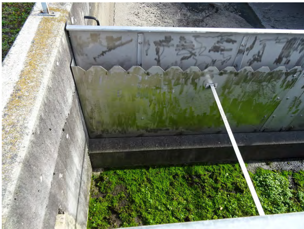
Abb. 3: Detail vom Überlauf im RÜB III
