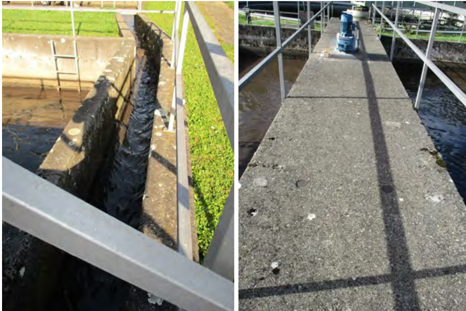
Abb. 7 und 8: Blick auf die Rinne und den Laufsteg über dem Becken
