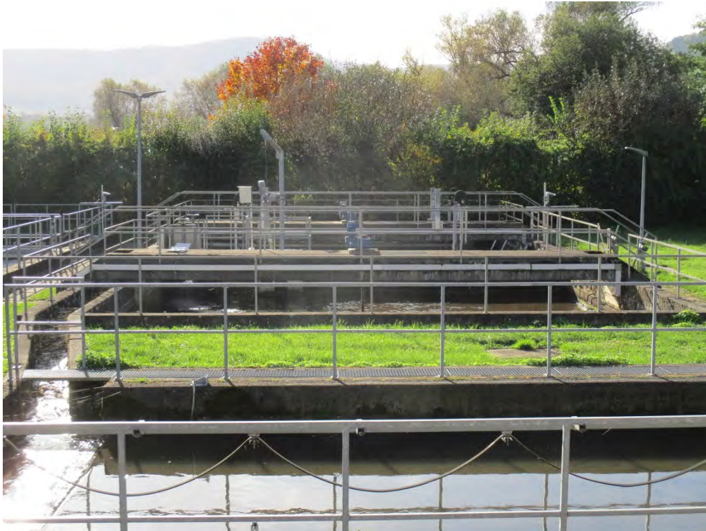
Abb. 6: Blick auf das Denitrifikationsbecken 1 (unterer Bildrand) und Denitrifikation 2 (Bildmitte)
