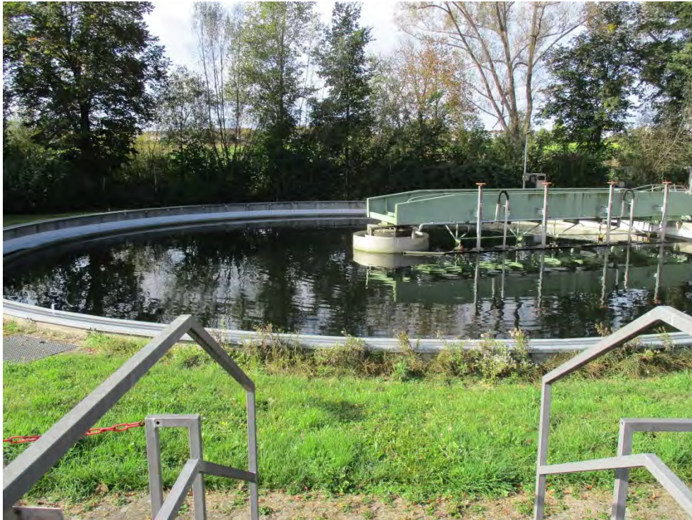
Abb. 18: Blick auf das Nachklärbecken
