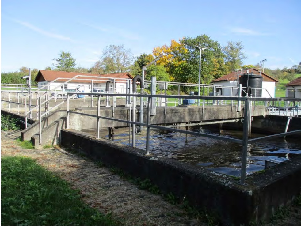
Abb. 16: Blick auf das Nitrifikationsbecken 2
