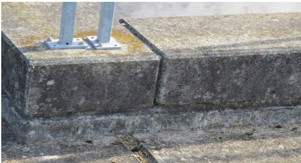
Abb. 13: Betonfertigteile auf der Wandkrone
