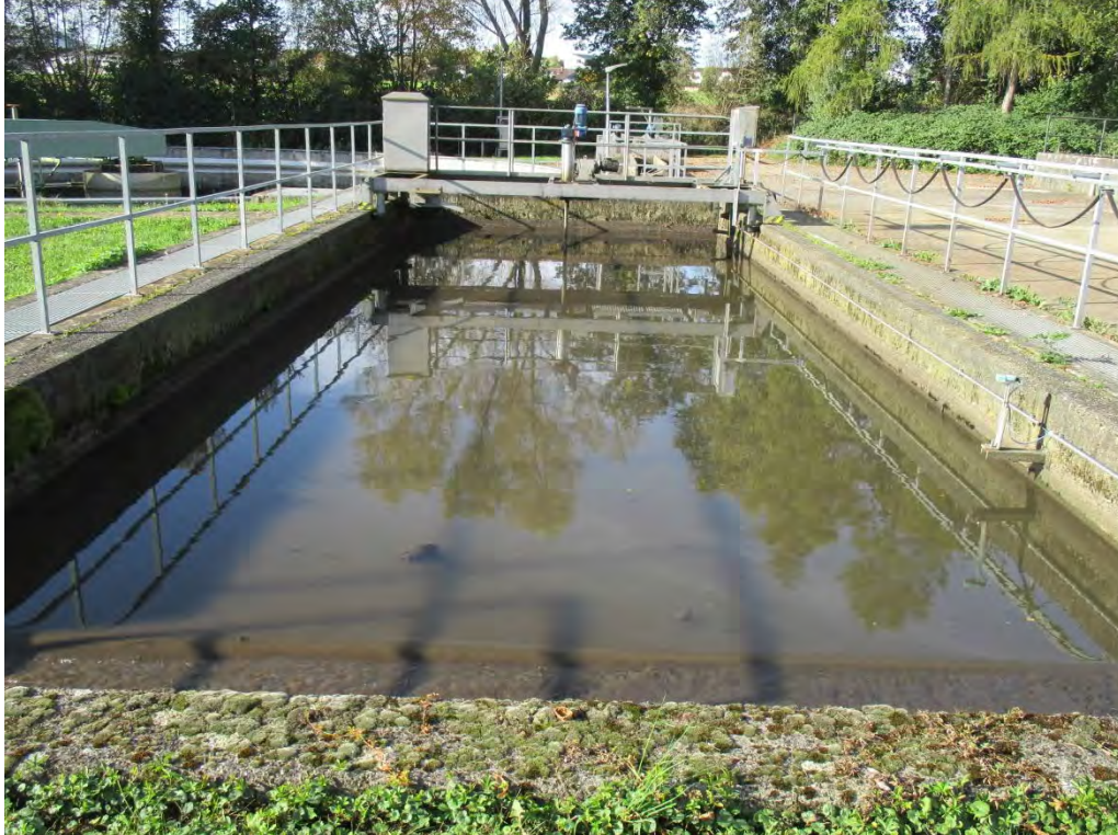
Abb. 2: Blick auf das Denitrifikationsbecken 1, im Vordergrund bemooste Wandkrone
