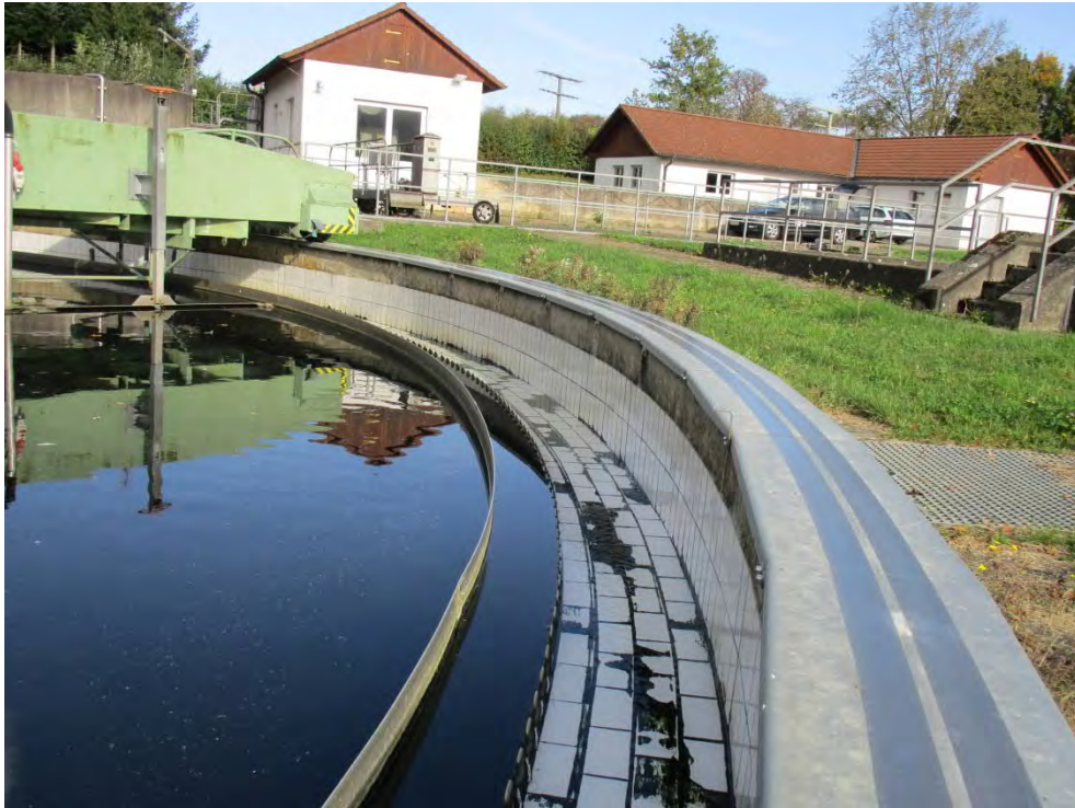
Abb. 19: Blick ins Nachklärbecken
