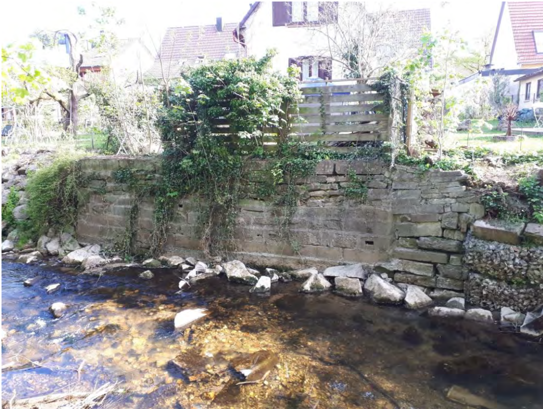
Ufermauer Untere Steinstraße 38/1
