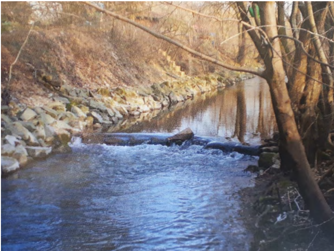
Querbauwerk 9 (Querbauwerke 9a, 9b und 10 sind vergleichbar)
