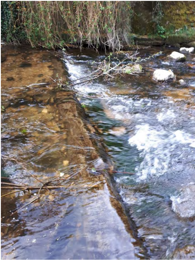
Querbauwerk 8 unterhalb Brücke Schlierbacher Straße
