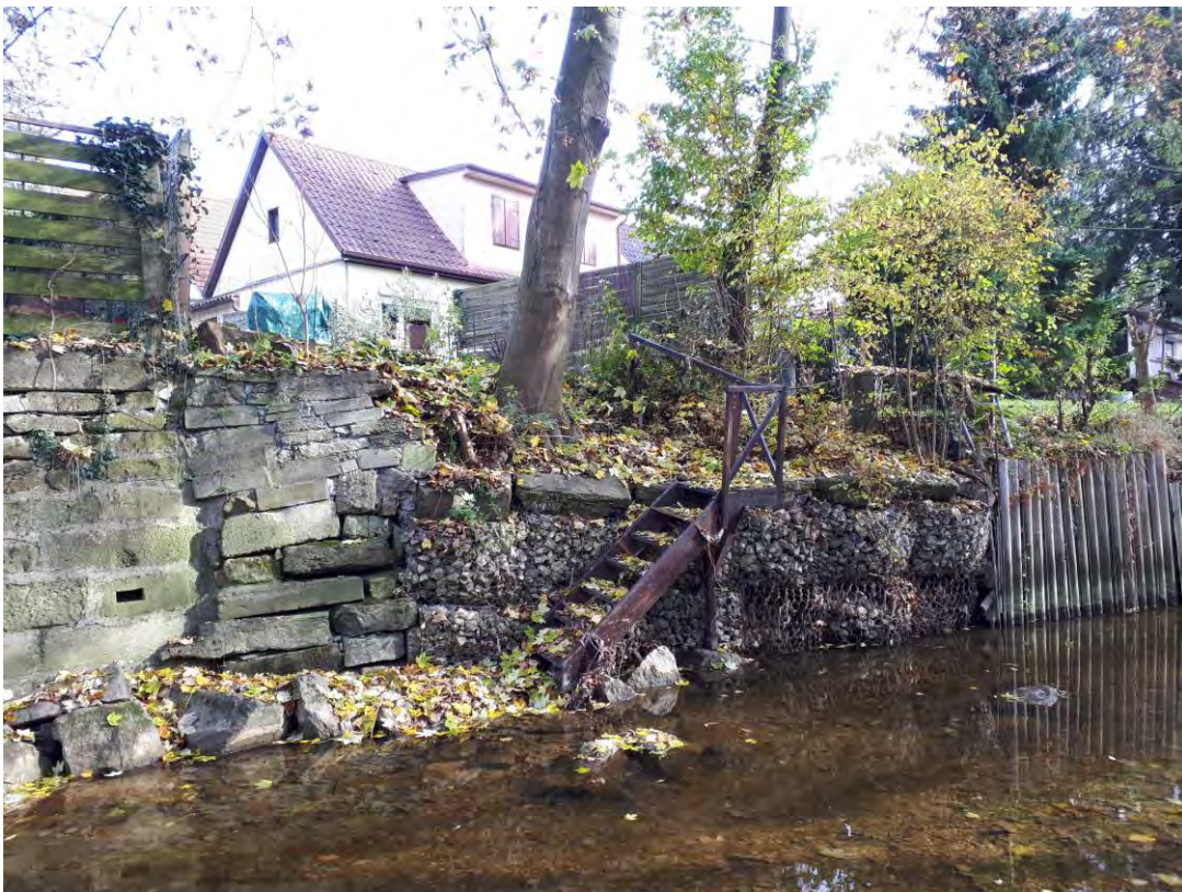
Ufermauer Untere Steinstraße 38
