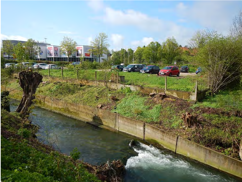
Ufermauer in Fließrichtung links, Höhe REWE
