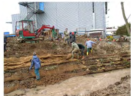
Beispiel: Einbau Geotextilsacke und Holzgrünschwelle
