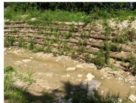
Beispiel: Böschungssicherung mit Holzgrünschwelle
