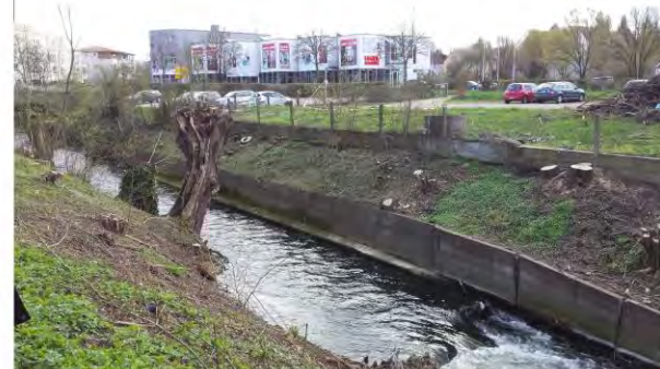
Blick auf die vorhandene Ufersicherung (Betonmauer) vom gegenüberliegenden Radweg
