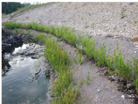
Beispiel: Böschungssicherung mit Geotextilsacke
