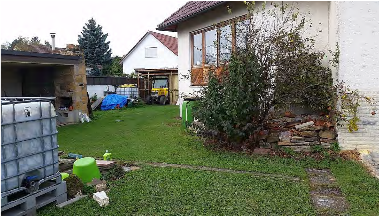
Abb. 3: Ziergarten mit dem Anbau und hinteren Teil der Garage. Diese Bereiche sollen zuerst zurückgebaut werden.
