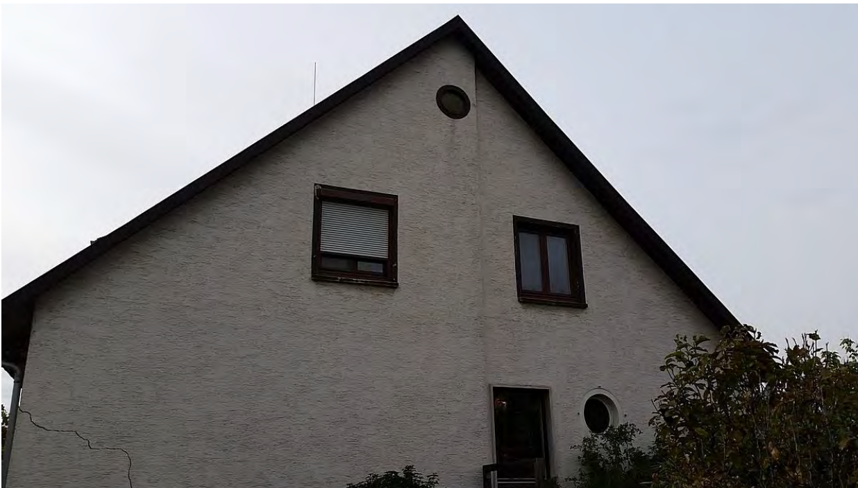
Abb. 4: Westseite des Bestandsgebäudes.
