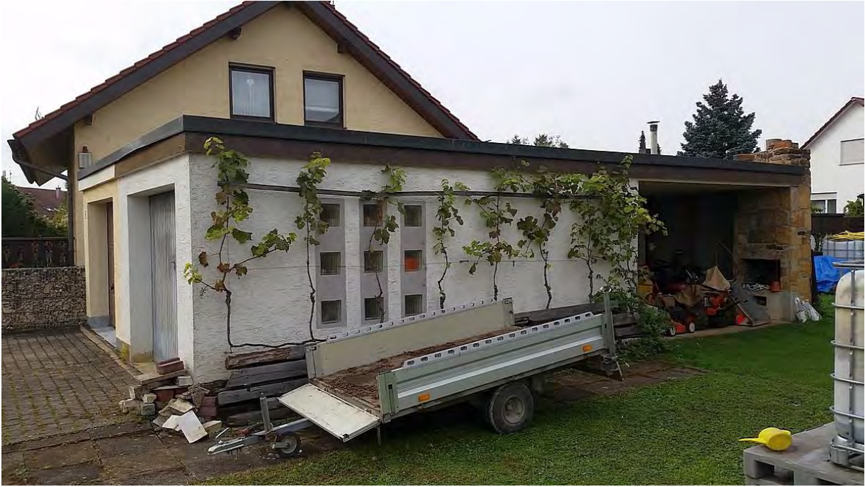
Abb. 5: Zum Rückbau vorgesehene Garage.
