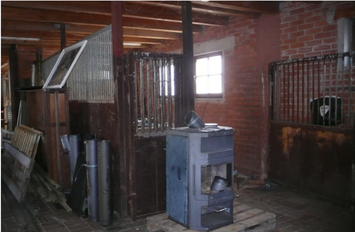
Abb. 9: Innenbereiche des Stallgebäudes auf Flurstück-Nr. 3120.
