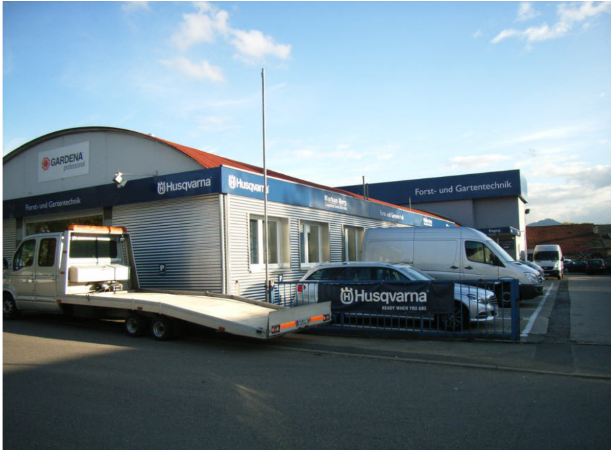
Abb. 3: Blick auf das Gewerbegebäude Zementstraße 18.
