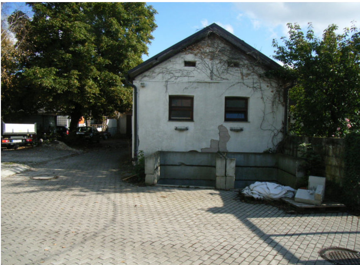
Abb. 8: Stallgebäude auf Flurstück-Nr. 3120.
