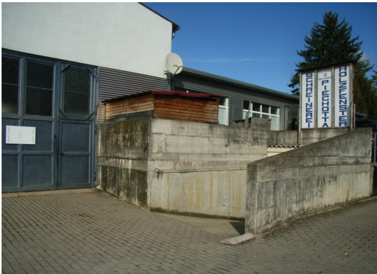
Abb. 6: Gewerbegebäude Zementstraße 16 mit Tiefgaragenzufahrt.
