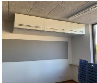
Beispiel dezentrales Raumluftgerät
