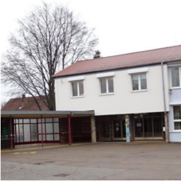
Abb. 5: Blick auf das bestehende Schulgebäude. Der linke Teil sowie das niedrige Toilettenhaus werden zurückgebaut, die Rotbuche im Hintergrund muss baubedingt entfernt werden.
