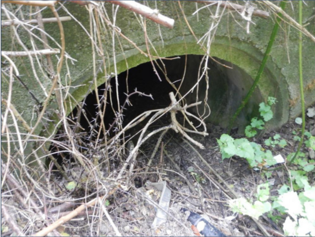
Abbildung 5.6 Einlaufbereich der Verdolong 34 (Stand: Ortsbegehung am 09.07.2020)
