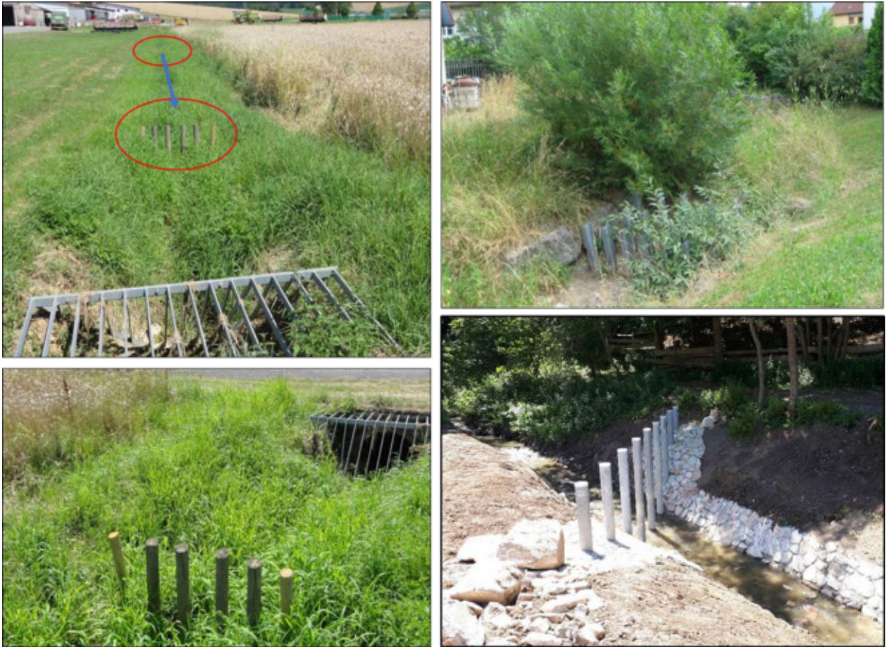
Abbildung 11.7 Kommunale bauliche Maßnahmen – Beispiele kleiner vorgeschalteter Grobrechen aus verschiedenen Materialien zum Rückhalt von angeschwemmten Grobmaterial und zusätzlichen Verlegungsschutz für Rechenbauwerke
