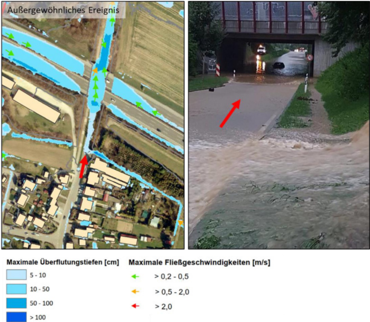
Abbildung 7.5 Außergewöhnliches Abflussereignis (links), Starkregenereignis in der Unterführung der A8 im Bereich der Ötlinger Straße am 11.06.0218 (rechts), Quelle: Stadt Kirchheim unter Teck
