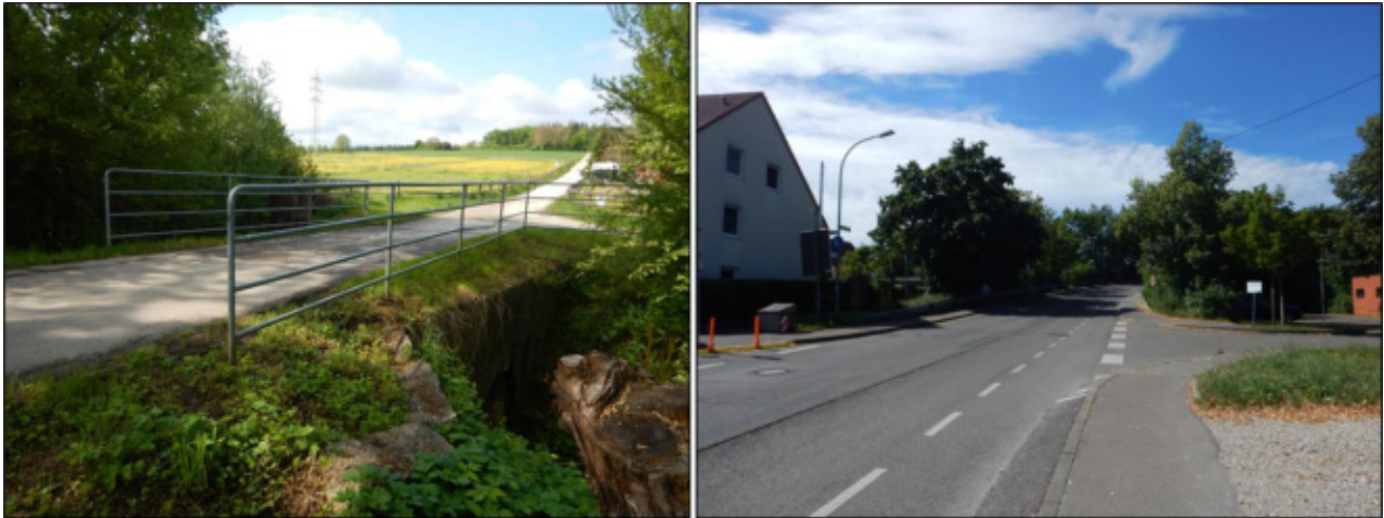
Abbildung 5.5 Brücke im Bereich „Zum Rübholz“ über den Dupiggraben (links) und Brücke im Bereich der Lindorfer Straße über die Bahnlinie (rechts)
