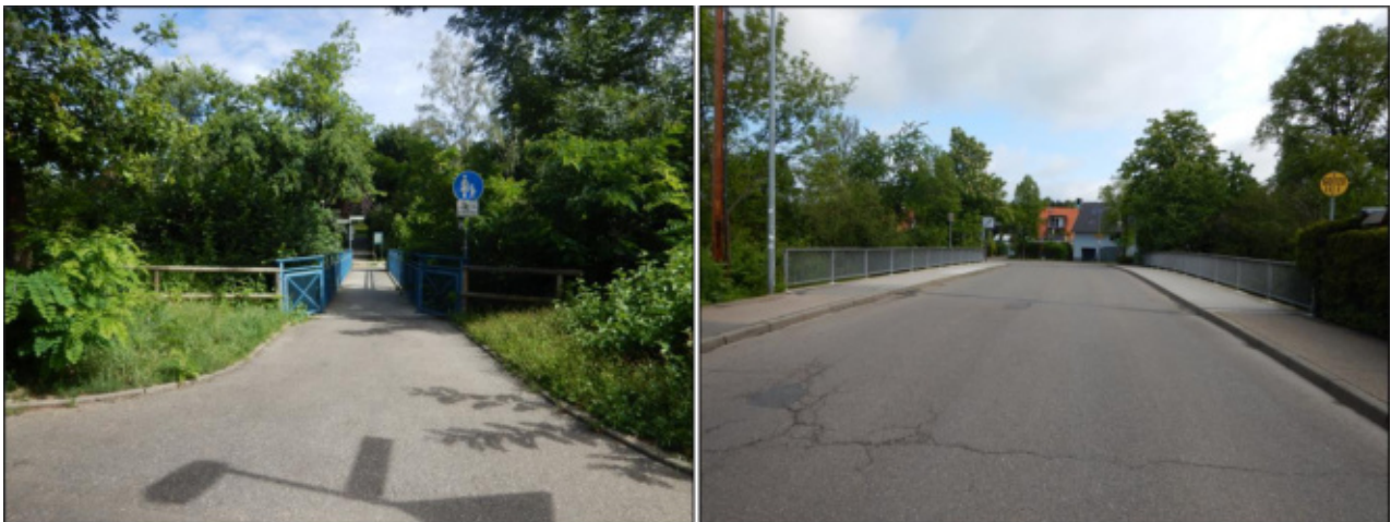
Abbildung 5.4 Brücke im Bereich der Bachstraße (links) und Brücke im Bereich der Schönblickstraße über die Lauter (rechts)
