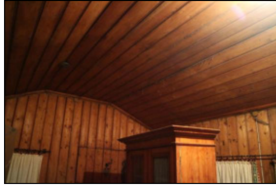
Ausgebautes Dach Turmhaus (B)
