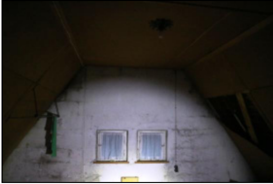
Dachstuhl Wohnhaus (B)
