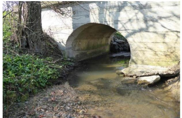
**Abbildung 32: Brückenbauwerk, Gewässersohle mit Sedimentauflage (Blick in Fließrichtung)**
