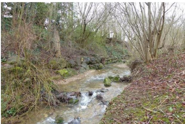
**Abbildung 102: Steinsatz als Uferverbau und Kiesbänke als Strukturen (Blick gegen Fließrichtung)**
