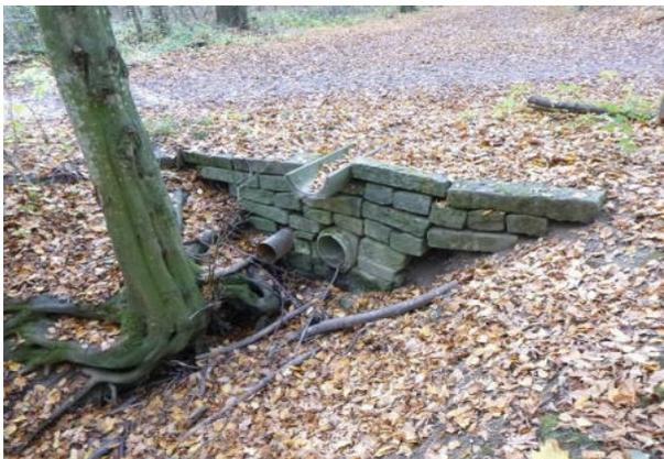
**Abbildung 99: Rohre unterhalb der Verdolung, z. T. wasserführend (Blick talaufwärts)**
