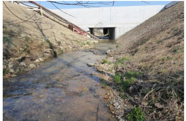
**Abbildung 24: Eingetieftes Profil oberhalb der neuen Bahnlinie (Blick in Fließrichtung)**
