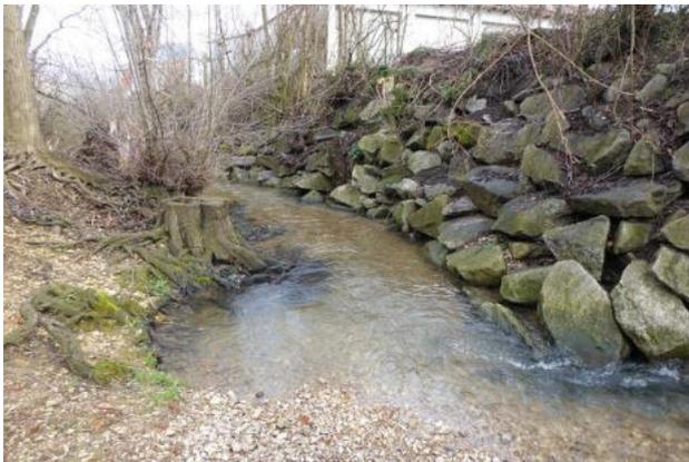
**Abbildung 108: Rechtsufriger Steinsatz aus großem Steinmaterial (Blick in Fließrichtung)**
