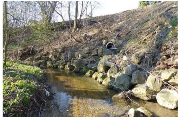
**Abbildung 34: Steinsatz als Ufersicherung am Prallhang (Blick gegen Fließrichtung)**
