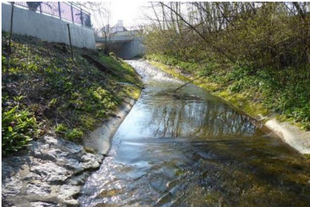
**Abbildung 33: Massiver Ufer- und Sohlverbau (Blick gegen Fließrichtung)**
