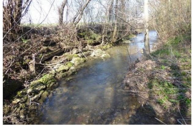
**Abbildung 63: Ehemalige Krainerwand mit Steinschüttung am Böschungsfuß (Blick in Fließrichtung)**
