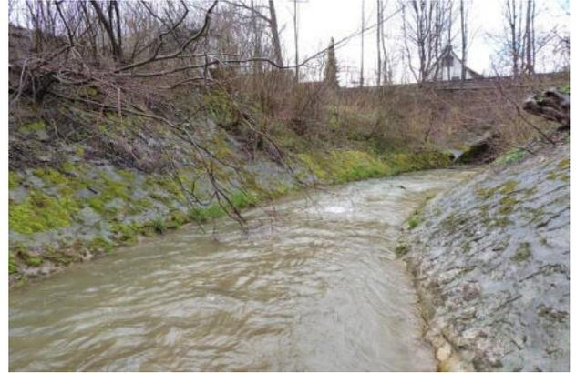
**Abbildung 15: Trapezprofil mit Böschungspflaster oberhalb der Bahnlinie (Blick in Fließrichtung)**
