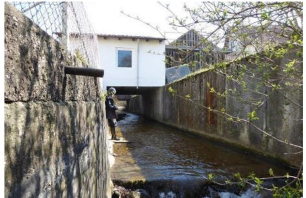
**Abbildung 40: Beidseitige Ufermauern und eine befestigte Sohle mit Sedimentauflage (Blick gegen Fließrichtung)**
