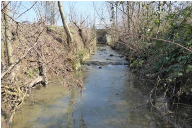
**Abbildung 59: Sohlabsturz unterhalb der Zufahrtsbrücke zur Baustelle (Blick gegen Fließrichtung)**
