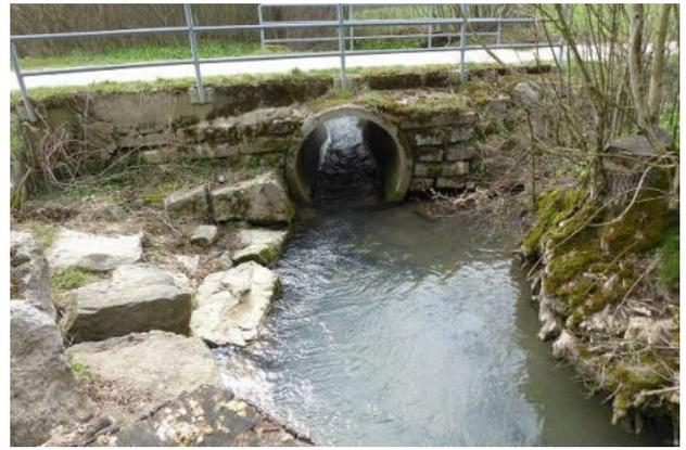
**Abbildung 71: Rohrdurchlass mit glatter Sohle
