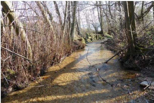
**Abbildung 31: Steinsatz als Ufersicherung (Blick gegen Fließrichtung)**
