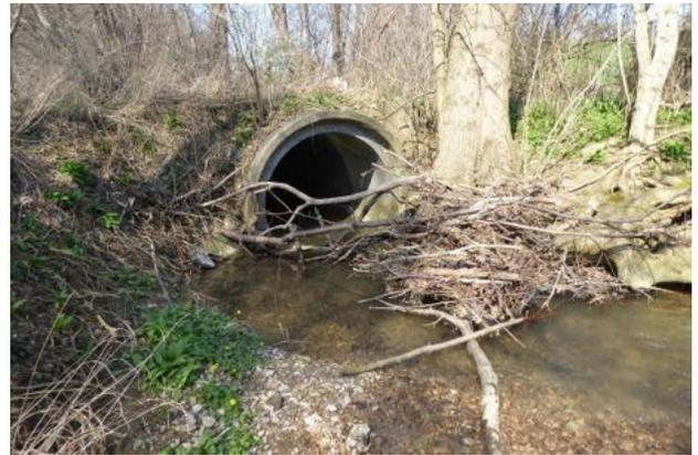
**Abbildung 58: Totholz oberhalb eines Rohrdurchlasses (Blick in Fließrichtung)**
