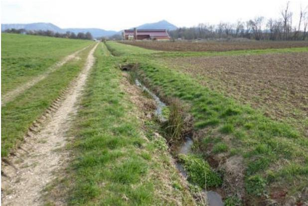
**Abbildung 89: Strukturen durch Bewuchs in der Grabensohle (Blick gegen Fließrichtung)**
