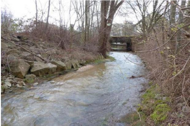
**Abbildung 12: Steinschüttung als Uferverbau unterhalb der Jesinger Straße (Blick gegen Fließrichtung)**
