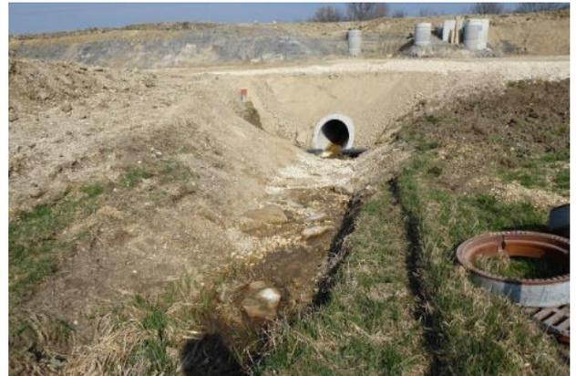
**Abbildung 86: Einlauf in die Verdolung im Bereich der Bahnbaustelle (Blick in Fließrichtung)**
