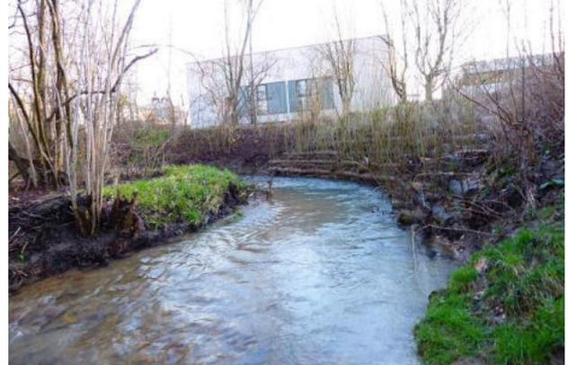
**Abbildung 20: Krainerwand als Ufersicherung entlang des Weges (Blick gegen Fließrichtung)**
