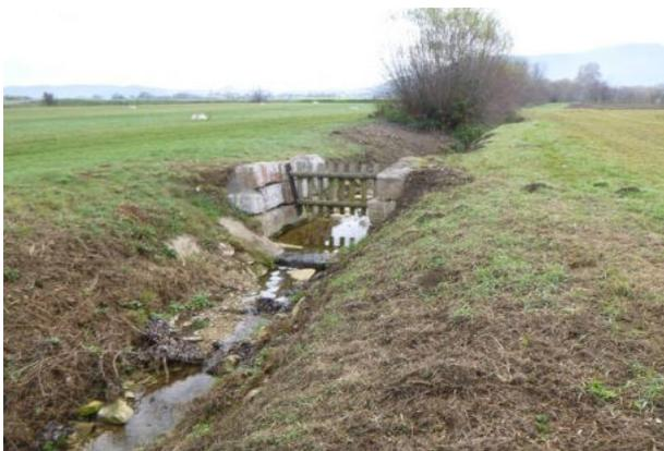
**Abbildung 114: Gitter als Getreibselfang (Blick gegen Fließrichtung)**
