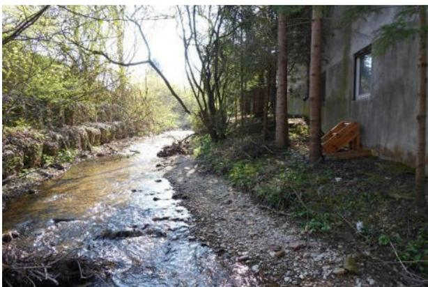
**Abbildung 35: Gabionen als Ufersicherung sowie Kiesbänke am Bach (Blick gegen Fließrichtung)**
