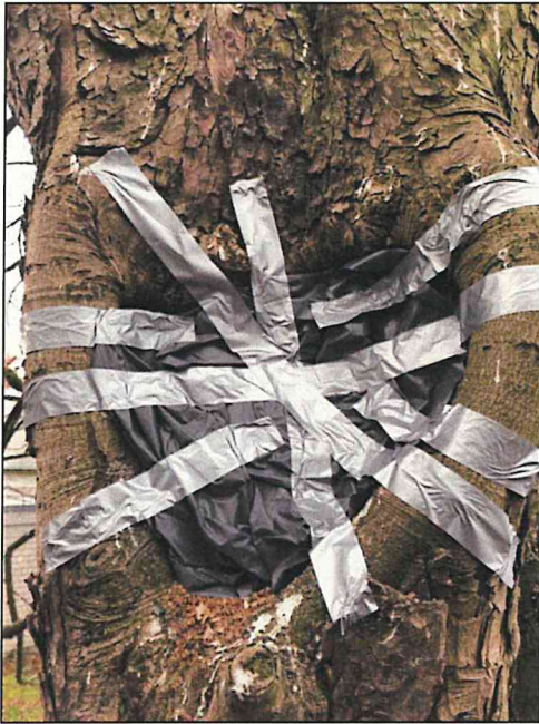
Verschlussene Schadstelle der Rosskastanie mit Schlupflöcher des Rosthaarbock
