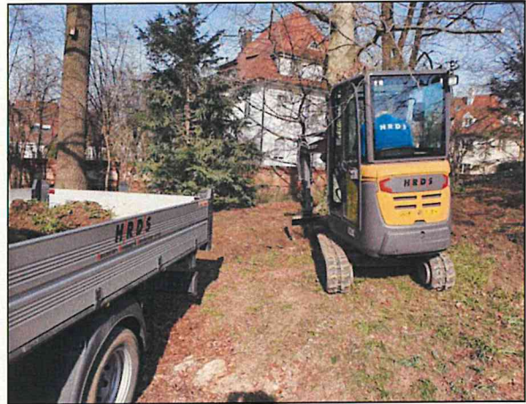
Verladen der Bodenschicht unter Einhaltung der natürlichen Bodenschichtung
