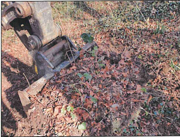
Ausbaggern mit einer Tiefe von 30 cm im Plangebiet unter Einhaltung der natürlichen Bodenschichtung
