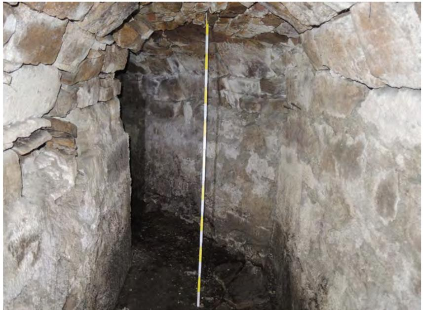
Abb. 2 - Blick in den Kanal aus hammerrechten Sandsteinen. Hier ein Meterstab, der die Scheitelhöhe bei ca. 1,78m angibt (2022)
