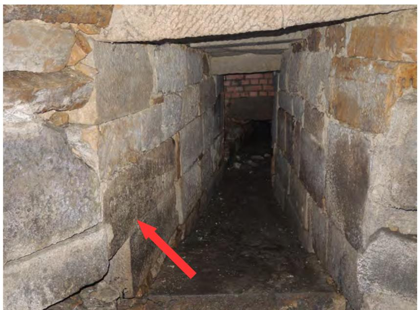
Abb. 3 - Der nach Norden abgehende Kanal wurde hingegen aus Sandstein-Quadern erbaut. Der rote Pfeil weist auf den Inschriftenstein (2022)
