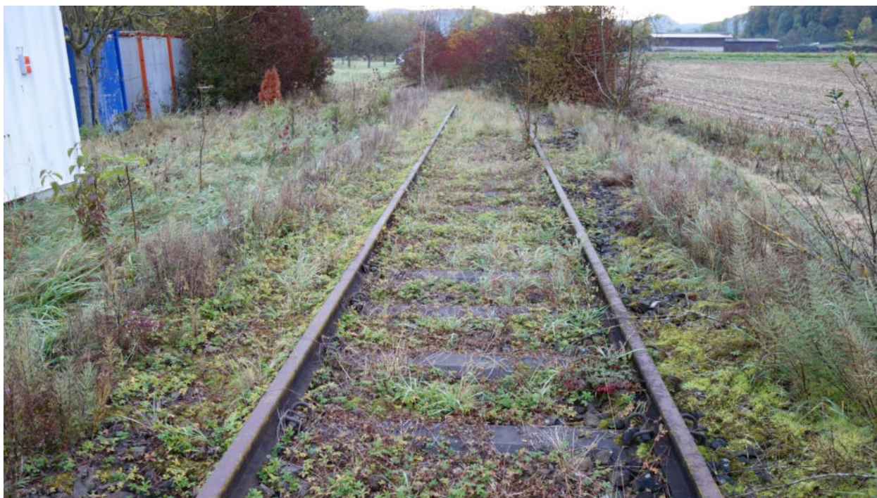
Abbildung 28: Abschnitt der aufgegebenen Bahnstrecke in Kirchheim Teck bei Jesingen
