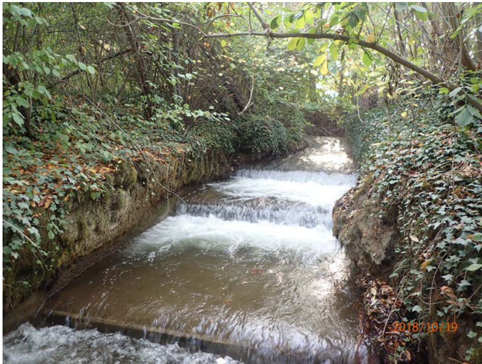
Abbildung 7: Im Mühlbach ist die Durchgängigkeit durch eine Absturzterrappe unterbrochen.
