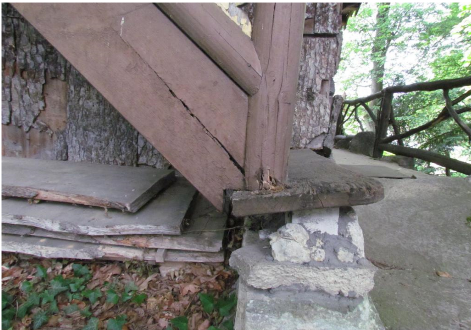
Bild 36: Treppensockel Nord- Ecke
