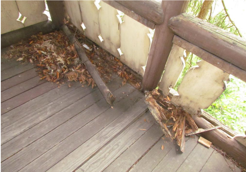
Bild 19: Unterer Geländerriegel (Holm), Süd - West, BT 128 / 130
