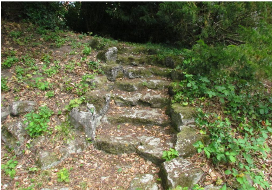
Bild 44: Treppenanlage östlich des Gartenhauses
