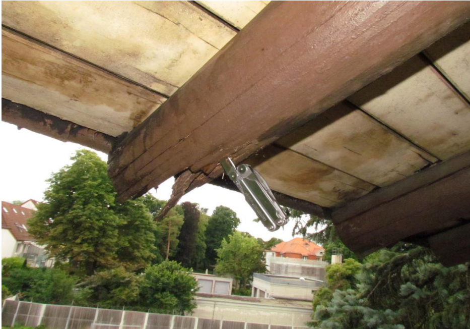
Bild 07: Sparrenkopf, BT 91, Traufe Süd - Ost
