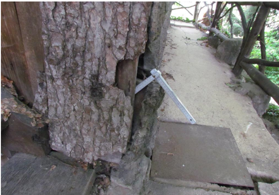
Bild 32: Aussenwand EG, Nord- Ecke, Blick von Nord - Ost
