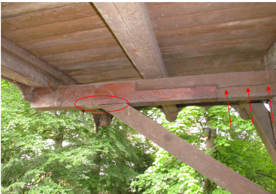
Bild 28: Wandrähm, West- Ecke, BT 1
