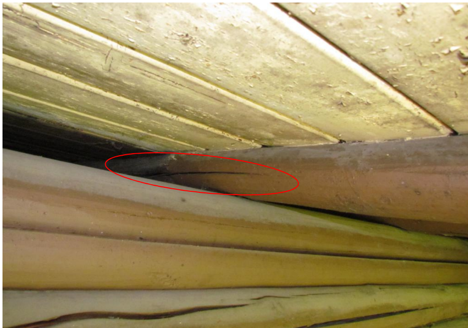
Bild 08: Sparren über Stubenwand, BT 89, Süd - Ost
