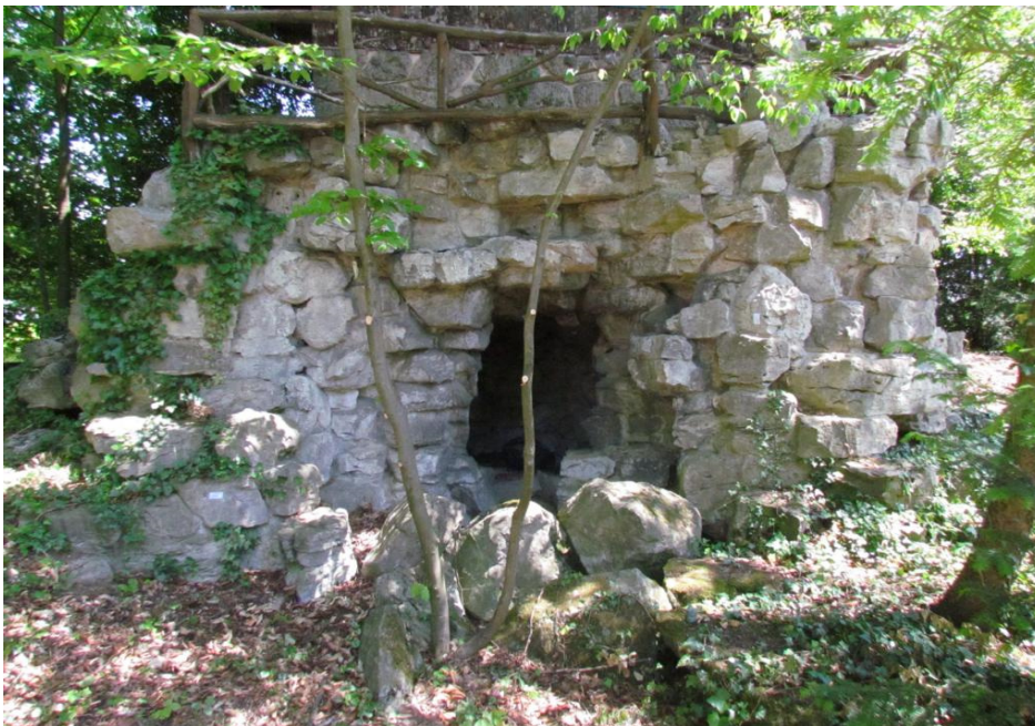
Bild 40: Blick auf den Grottenbereich von Süd - Westen
