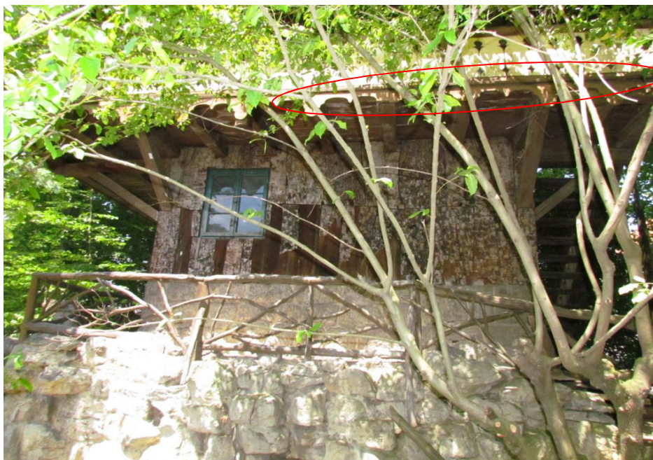
Bild 22: Zierblende Süd - Ostfassade
