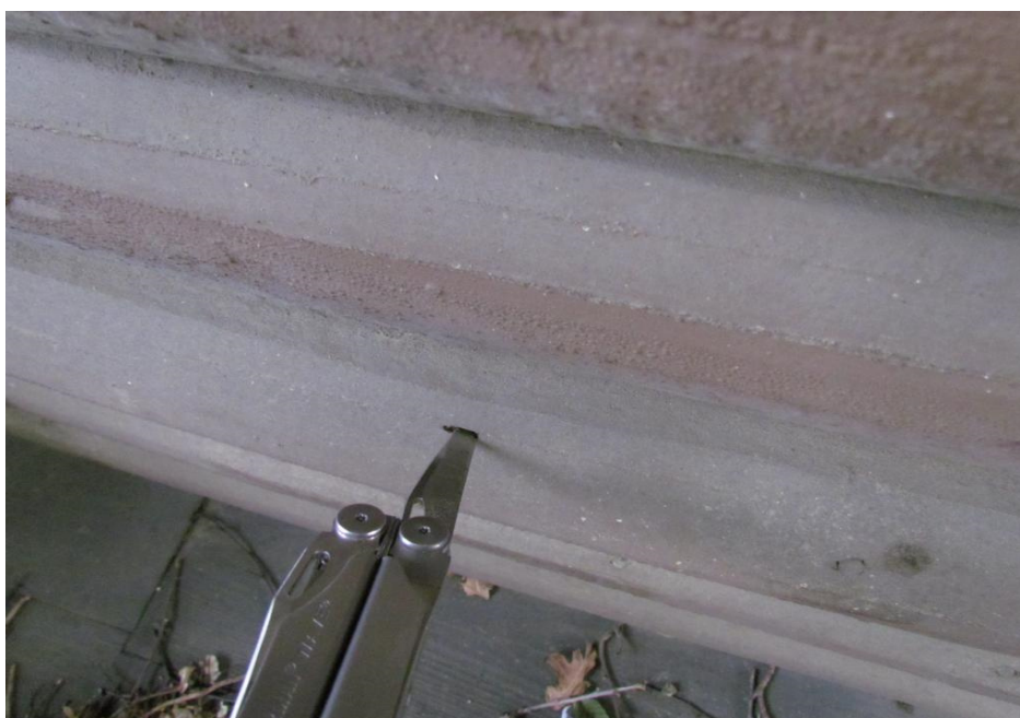
Bild 12: Rundbohlenwand Nord - West, DG, Detail unter Fenster
