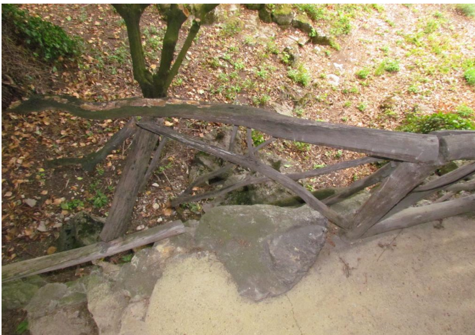
Bild 38: Geländer EG, Süd - Ostseite
