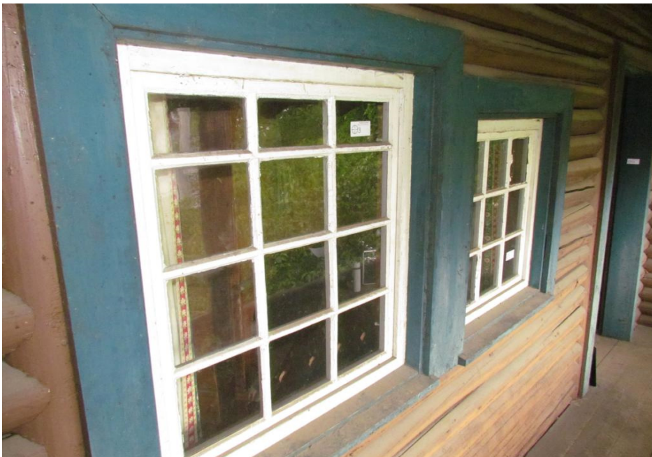
Bild 34: Fenster DG, Süd - Ostwand, von aussen
