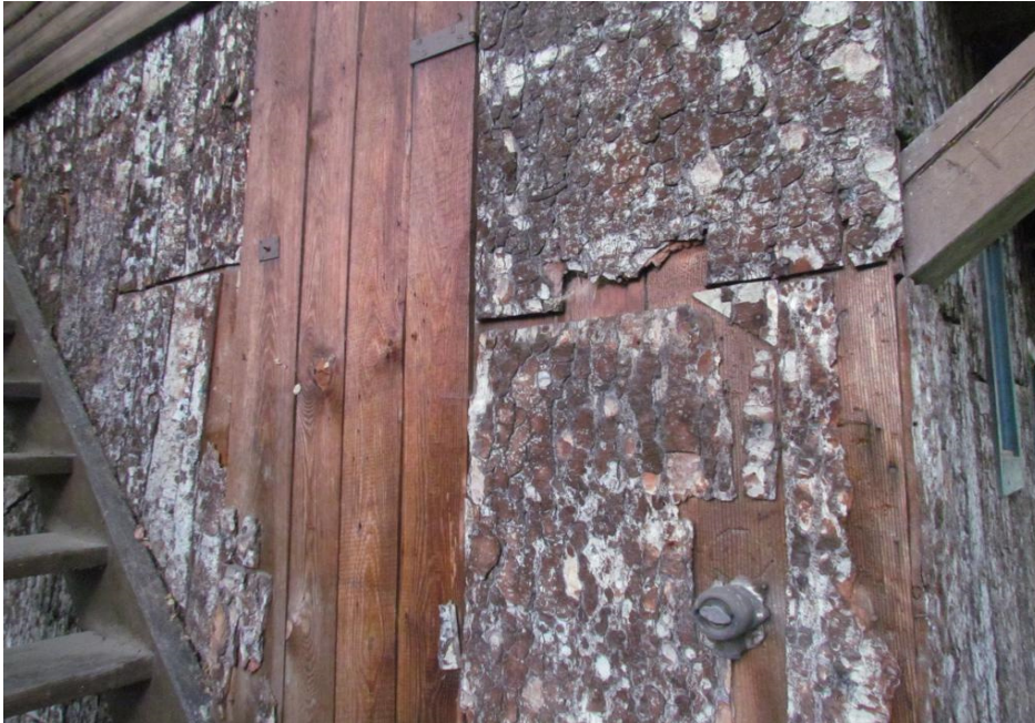
Bild 31: Aussenwand EG, Nord - Ost
