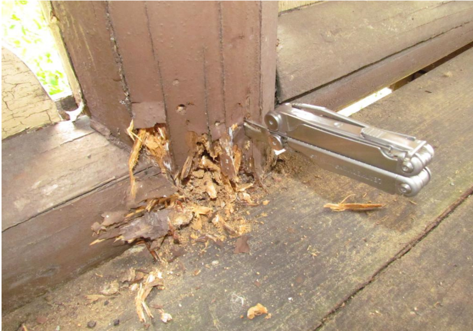
Bild 17: Stütze, Süd - Ost, Mitte, BT 116
