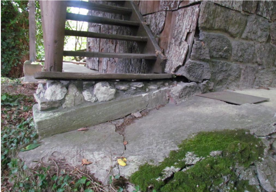
Bild 37: Treppensockel Nord- Ecke
