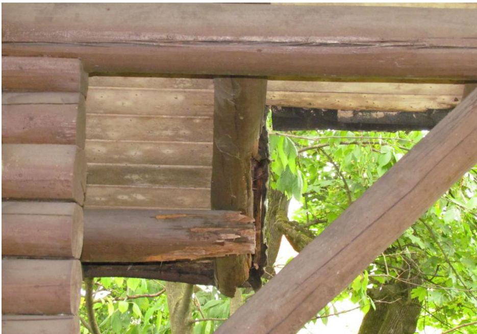
Bild 10: Dachkante Nord- Ecke
