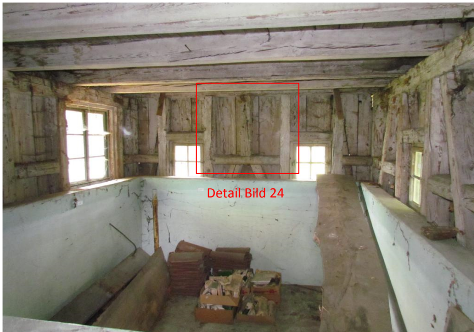
Bild 23: Innenraum Erdgeschoss, Blick nach Süd - Westen
