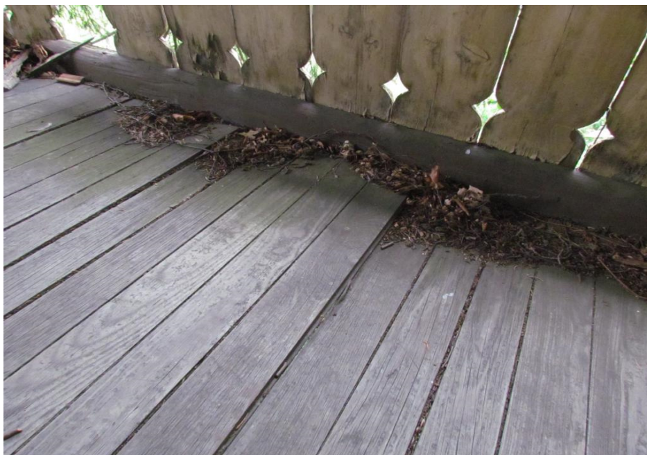
Bild 21: Balkonboden Süd - West
