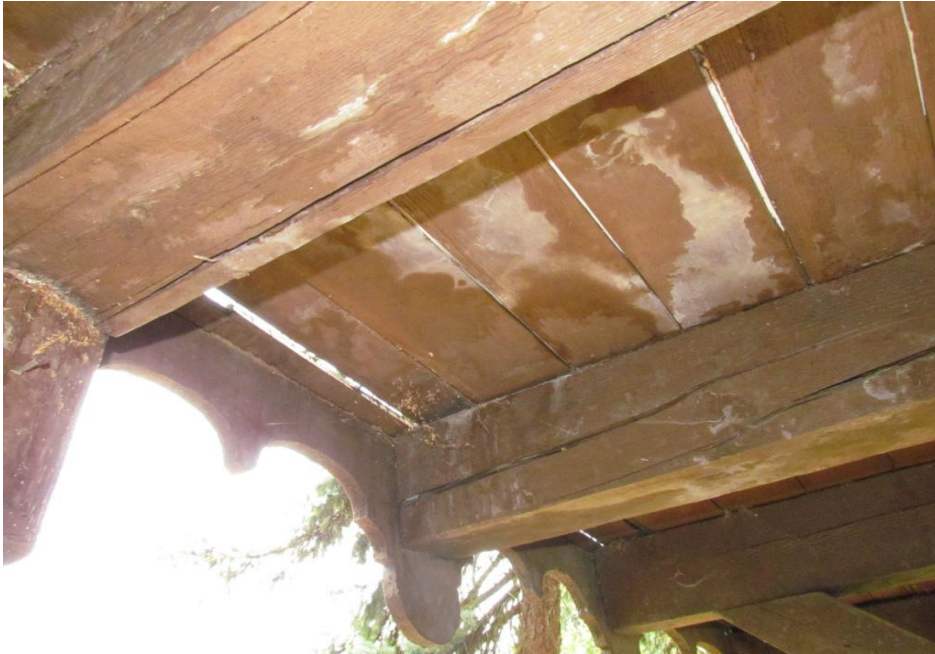
Bild 27: Auskragende Deckenbalken über EG, Süd - Ost, BT 5, 6, 7
