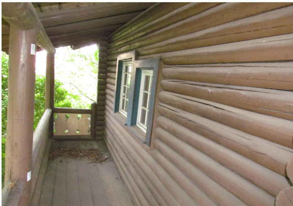
Bild 11: Rundbohlenwand Nord - West, DG, von aussen
