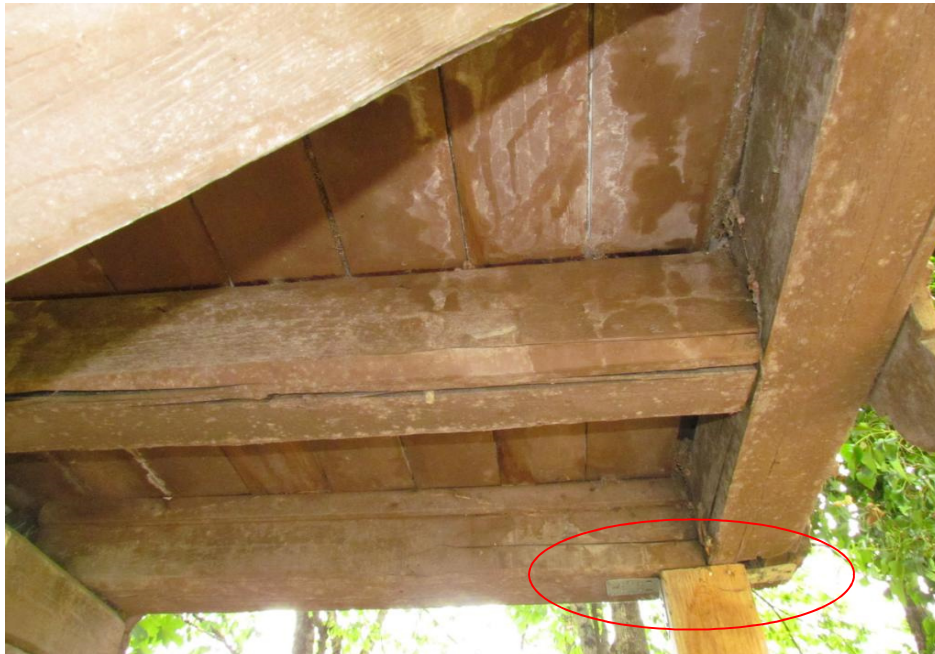
Bild 29: Treppenpodest, Ostecke, BT 12, 13, 14
