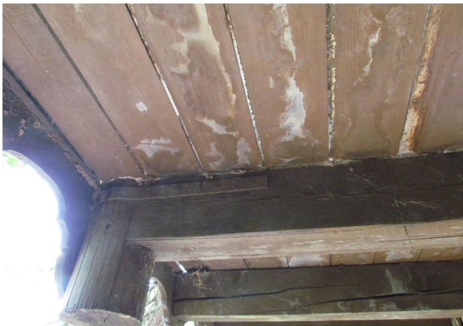
Bild 05: Untersicht Balkon (Decke über EG)
