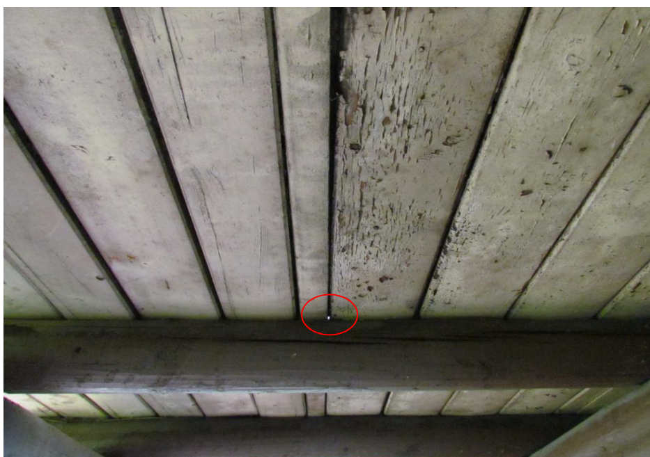
Bild 04: Dachuntersicht aussenliegend, exemplarisch
