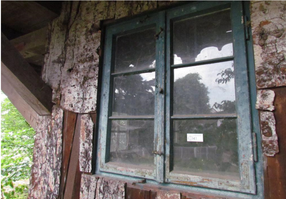
Bild 35: Fenster EG, Süd - Ostwand, von aussen
