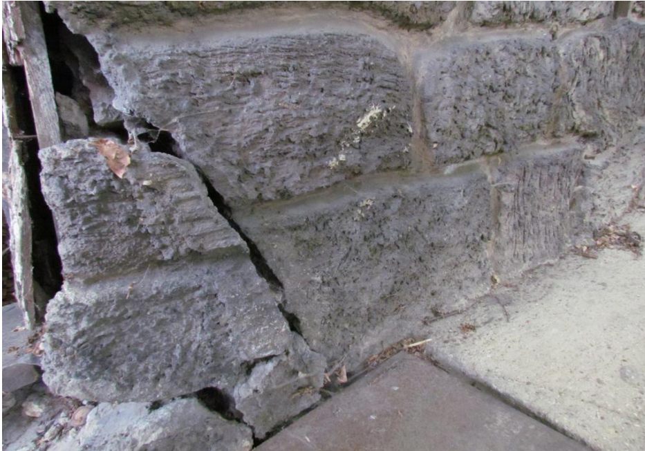
Bild 33: Aussenwand EG, Nord- Ecke, Blick von Nord - West
