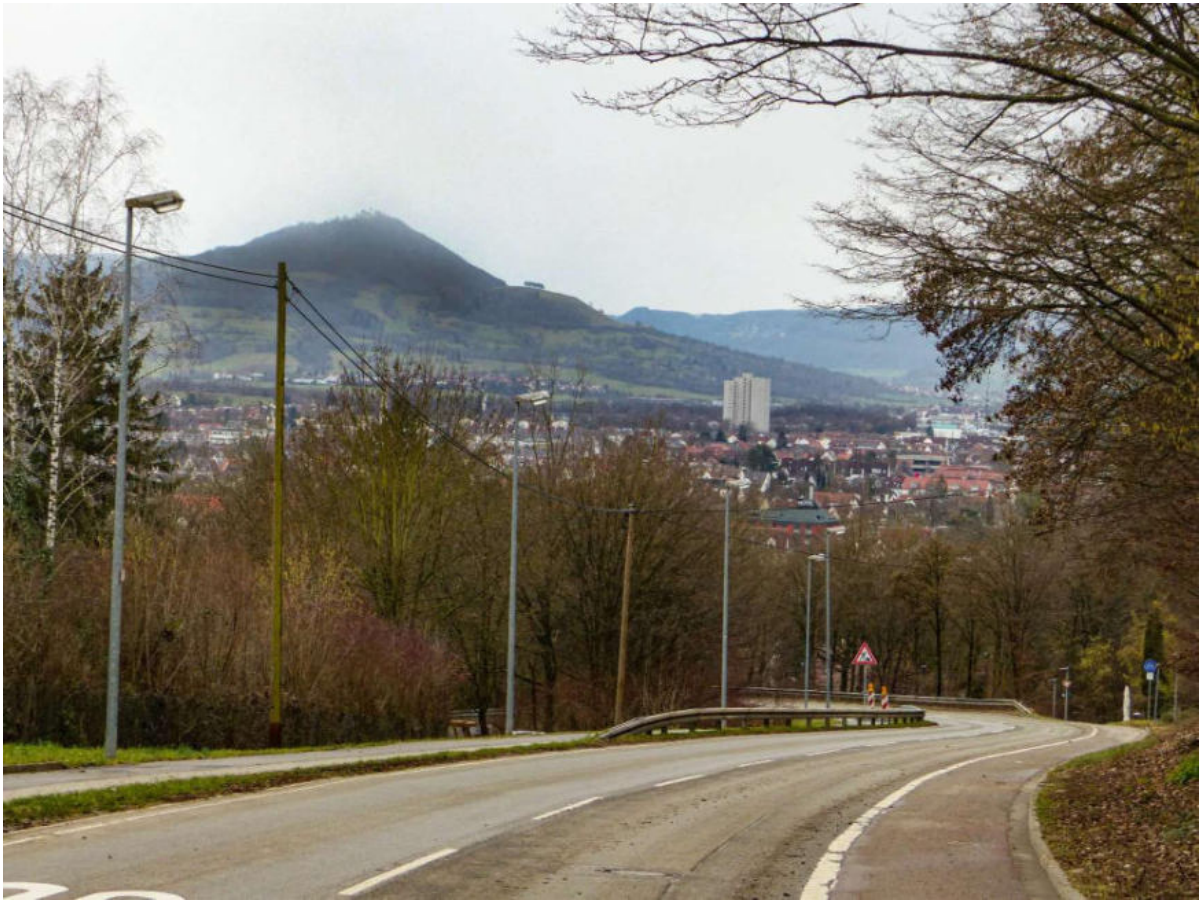
Ansicht Notzinger Steige
