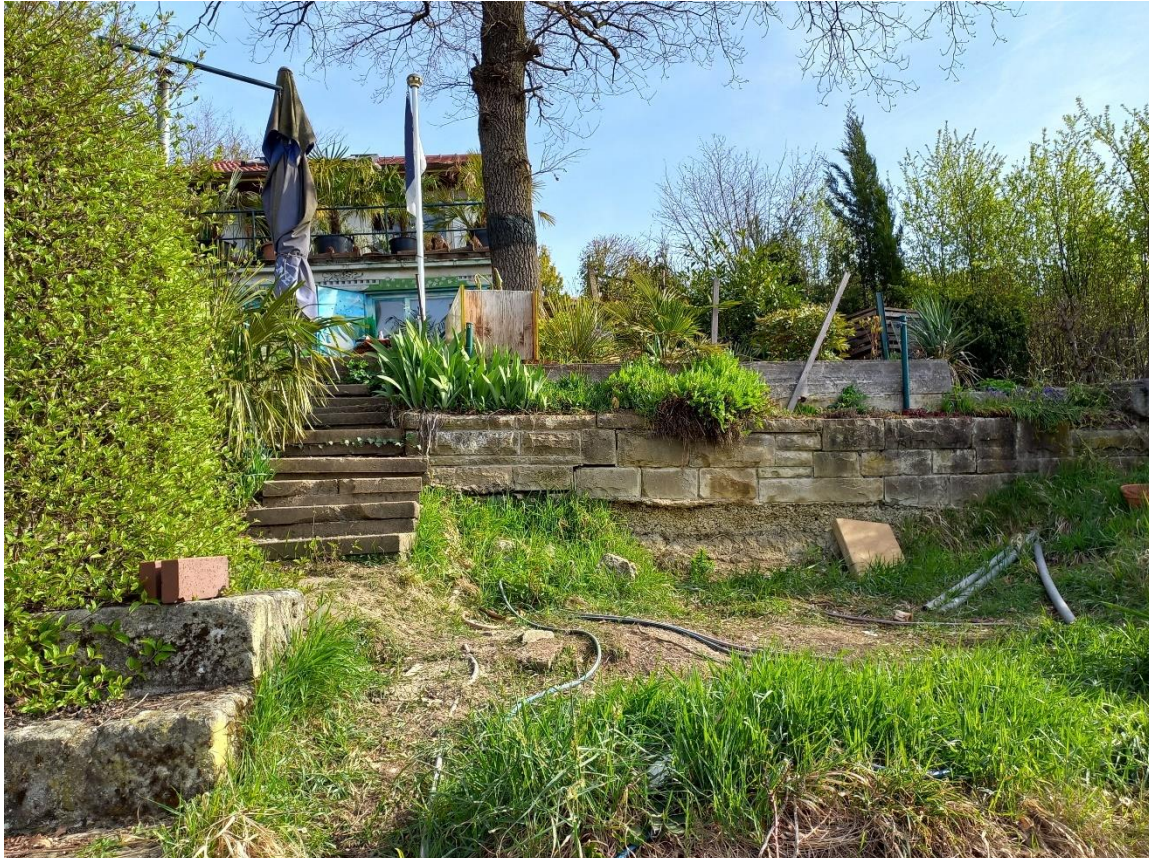
Abbildung 7: Blick vom Garten auf das Haus. Freifläche mit Treppe und Mauer.
