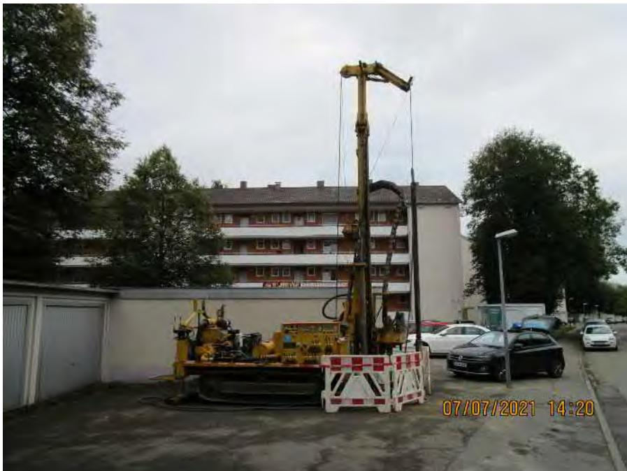
**Bild 1: Kernbohrung BK 1**
