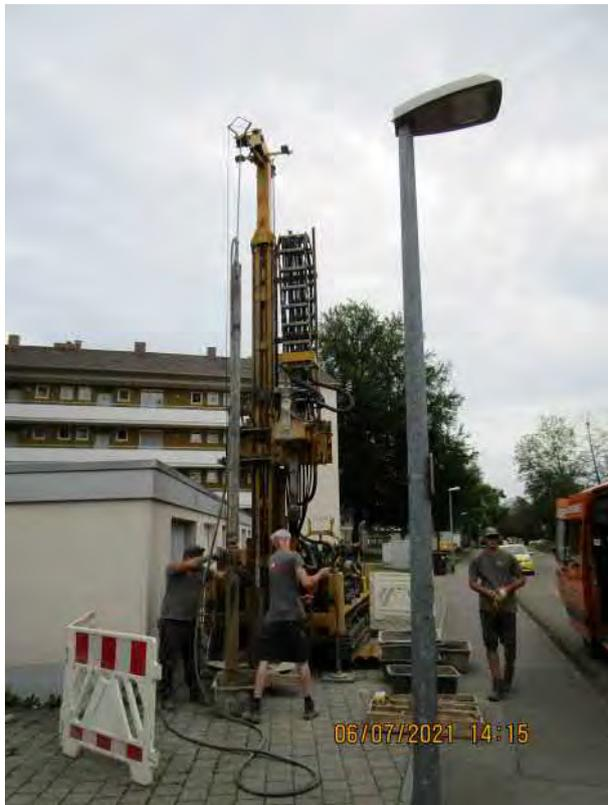
**Bild 2: Kernbohrung BK 2**
