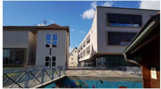
Blick vom Lindachufer auf Freihoftschulareal mit Ostflügel links, Schlössle hinten Mitte und Hauptgebäude rechts
