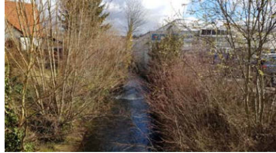
Blick von Brücke Plochingen Straße auf Lautach und Autohaus Hammerschmiedegasse rechts
