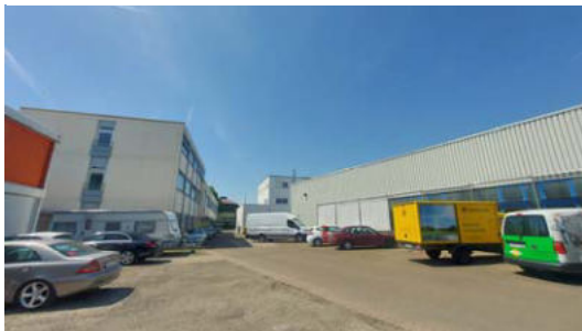
Blick von Nordosten auf Schulgebäude Hammerschmiede links sowie Hof und Gebäude Autohaus Mitte und rechts
