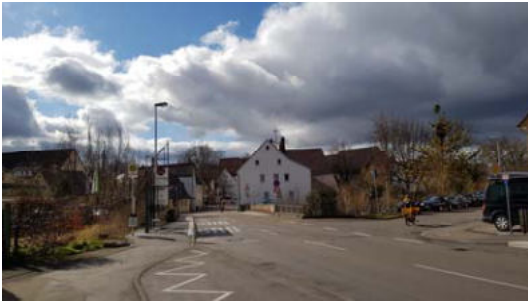
Plochinger Straße, Zufahrt von Norden in das Untersuchungsgebiet über Lauterbrücke
