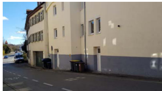
Alleenring Einbahnbereich Nord: Blick von Westen auf Nr. 128 (links) und 130 (rechts)
