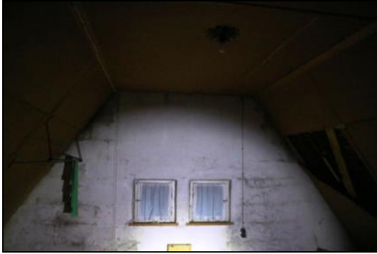
Dachstuhl Wohnhaus (B)
