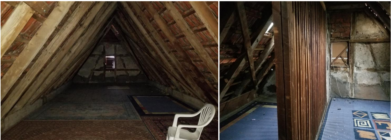
Abb.4: Dachboden des Wohngebäudeteils
