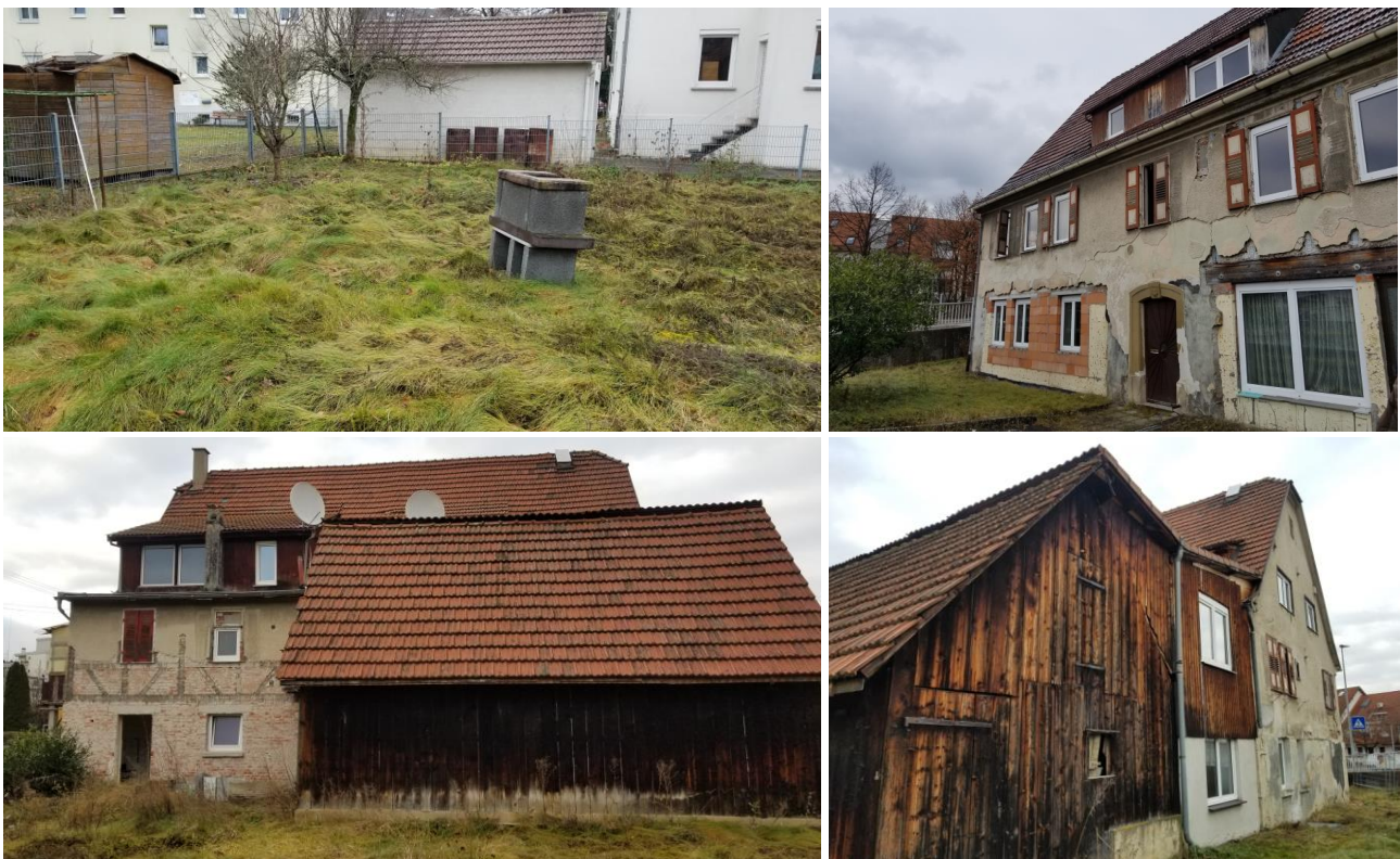
Abb.3: Bestandsgebäude und Grundstück
