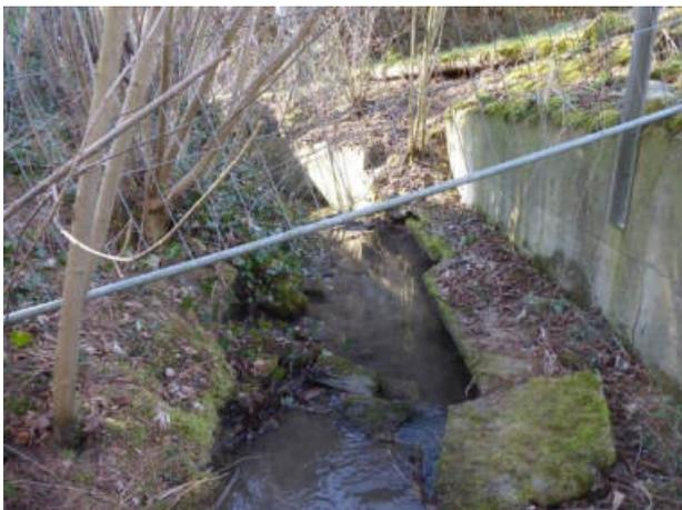
**Abbildung 47: Gitterzaun über Gewässer und rechtsufrige Ufermauer (Blick in Fließrichtung, Abschnitt 41)**
