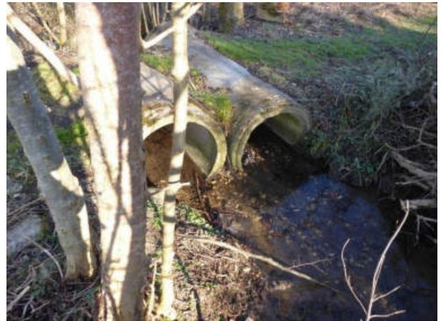
**Abbildung 44: Gewässerüberfahrt bestehend aus zwei nebeneinander liegenden Rohren (Blick gegen Fließrichtung, Abschnitt 39)**
