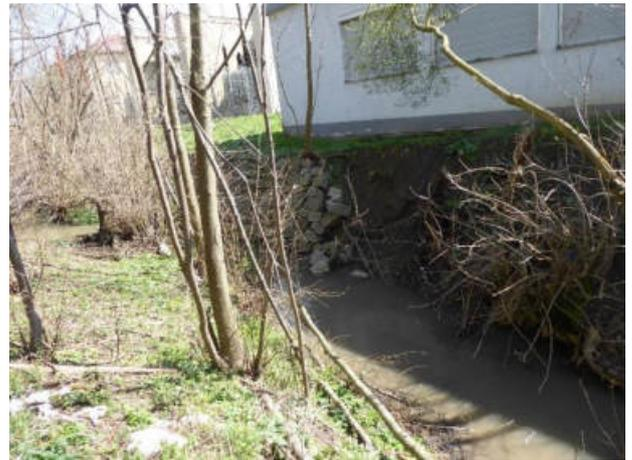
**Abbildung 35: Zerfallende Uferbefestigung und Uferabbruch direkt vor Gebäude (Blick gegen Fließrichtung, Abschnitt 18)**
