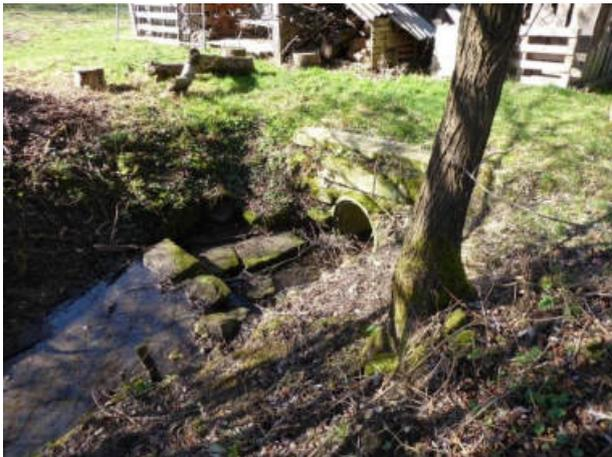
**Abbildung 60: Sohlabsturz mit anschließendem Einlauf in die Verdolung in Abschnitt 9 (Blick in Fließrichtung, Abschnitt 10)**
