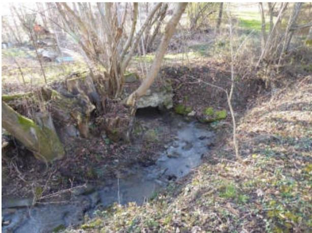
**Abbildung 42: bedingt durchlässiger Rohrdurchlass in Form eines Maulprofilen (Blick gegen Fließrichtung, Abschnitt 36)**
