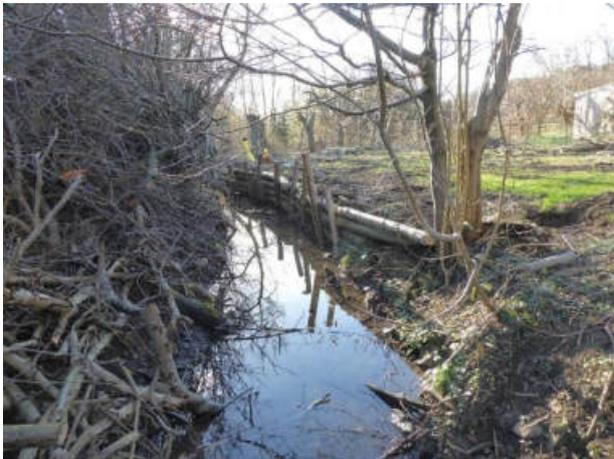
**Abbildung 43: Rechtsufriger Stangenverbau mit Uferauffüllung dahinter, linksufriger Grünschnitt (Blick gegen Fließrichtung, Abschnitt 38)**
