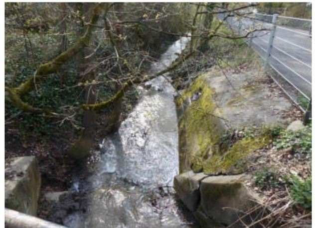
**Abbildung 10: Auslauf aus der Verdolung mit anschließender rechter Ufermauer zur Böschungssicherung (Blick in Fließrichtung, Abschnitt 3)**
