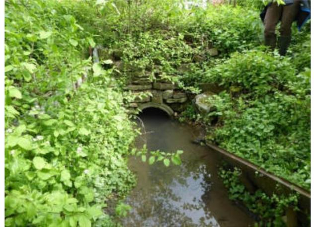
**Abbildung 22: Auslauf aus der Verdolung mit wildem Uferverbau aus Metallplatten (Blick gegen Fließrichtung, Abschnitt 19)**
