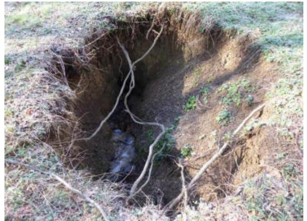
**Abbildung 74: Bodeneinbruch mit am Grund verlaufendem Tobelbach (Abschnitt 10)**
