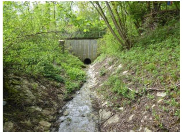
**Abbildung 18: Einlauf in die Verdolung mit Ufer- und Sohlbefestigung (Blick in Fließrichtung, Abschnitt 15)**
