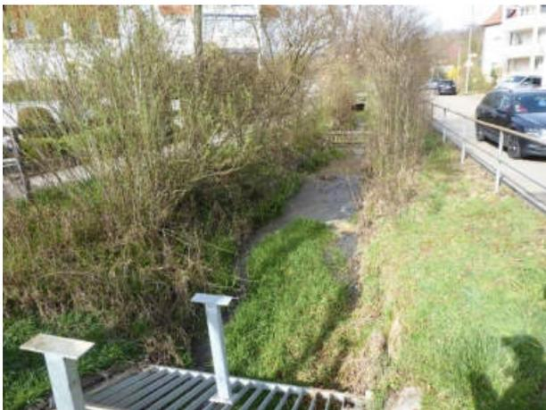
**Abbildung 12: Weppach oberstrom des Einlaufs in die Verdolung. Zu sehen sind der Rechen und ein Gewässerbett mit bewachsener Berme (Blick gegen Fließrichtung, Abschnitt 5)**
