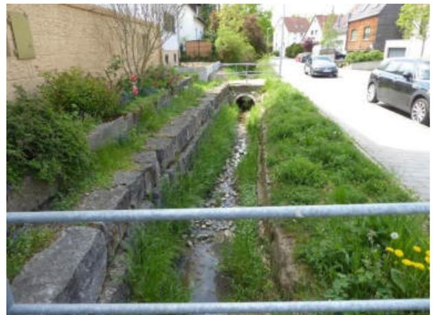
**Abbildung 13: Beidseitige Uferbefestigung über Steinsatz und immer wieder unterbrochener Gewässerlauf durch zahlreiche Durchlässe (Blick in Fließrichtung, Abschnitt 7)**
