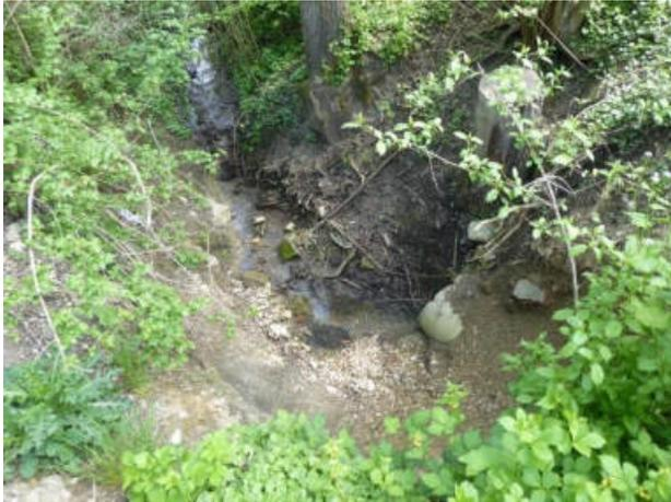
**Abbildung 16: Sehr tief liegende Weppach mit Uferabbruch, Einlauf in den Durchlass in Abschnitt 12**
