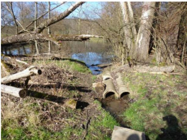
**Abbildung 57: Gewässerüberfahrt aus zwei Rohren (Blick in Fließrichtung, Abschnitt 4)**
