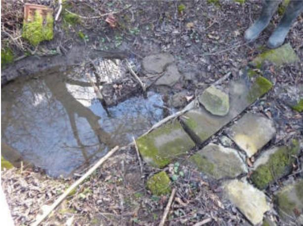
**Abbildung 50: Ausleitung zu den Fischeichen mit anschließender Sohlbefestigung (Abschnitt 45)**
