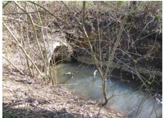
**Abbildung 31: Auslauf aus der oberstromigen Verdolung mit rechtsufriger Uferbefestigung (Blick gegen Fließrichtung, Abschnitt 20)**
