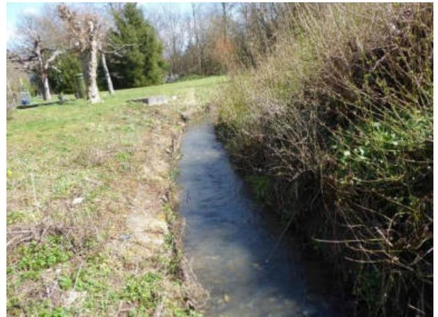
**Abbildung 33: Rechtsseitiger durchgehender wilder Uferverbau (Blick gegen Fließrichtung, Abschnitt 10)**
