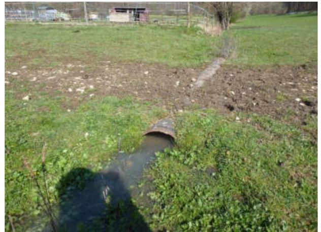
**Abbildung 71: Rohrdurchlass als Gewässerüberfahrt (Blick gegen Fließrichtung, Abschnitt 3)**
