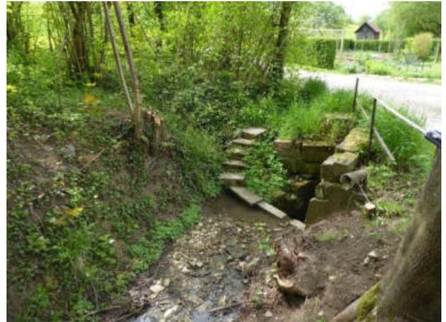
**Abbildung 24: Einlauf in die Verdolung in Abschnitt 21 über künstlichen Sohlabsturz (Blick in Fließrichtung)**
