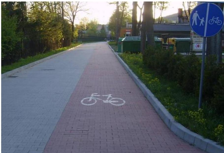
**Bild 27** Umgang mit getrennten Geh- und Radwegen bei gleicher Bauweise
