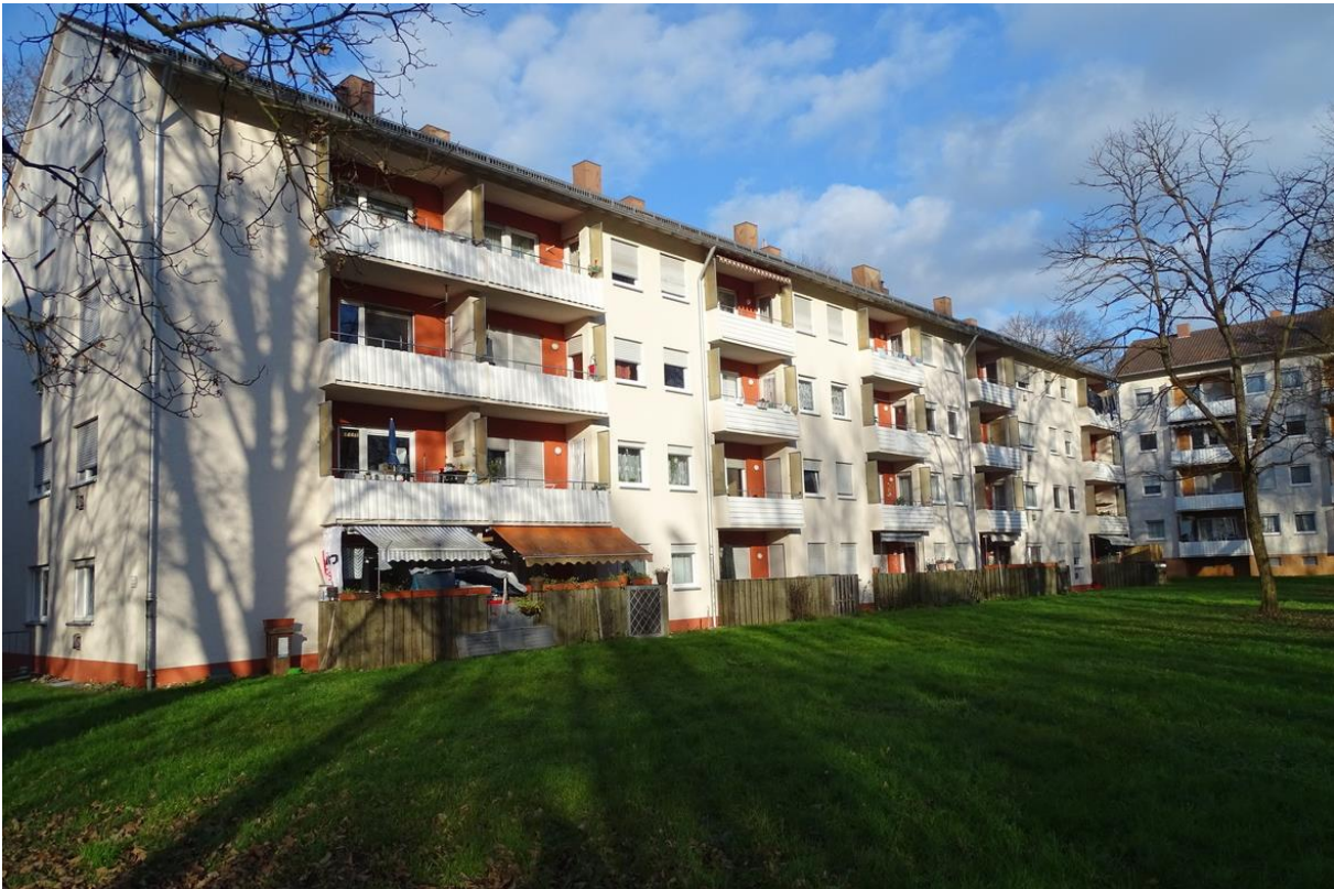
Abb. 1: Die vier von Teilabschnitt 1 betroffenen Wohnhausblöcke sind in weitestgehend identischer Bauweise errichtet und orthogonal zueinander angeordnet.
