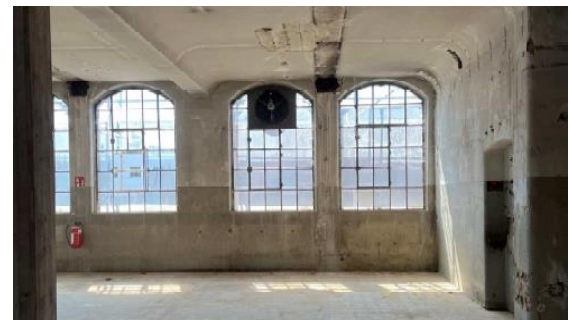
Abbildung 13: Fenster Quelle: Eigentümer / Architekturbüro
