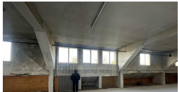
Abbildung 11: Deckenhöhe / Fensterposition Quelle: Aufnahme Eigentümer / Architekturbüro
