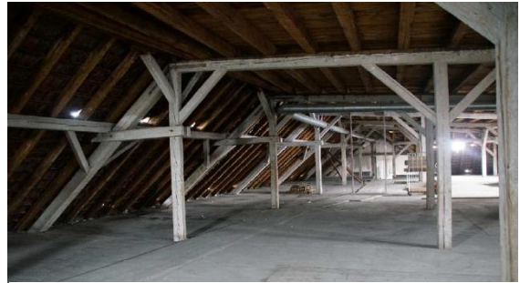
Abbildung 12: Dachstuhl Quelle: Eigentümer / Architekturbüro
